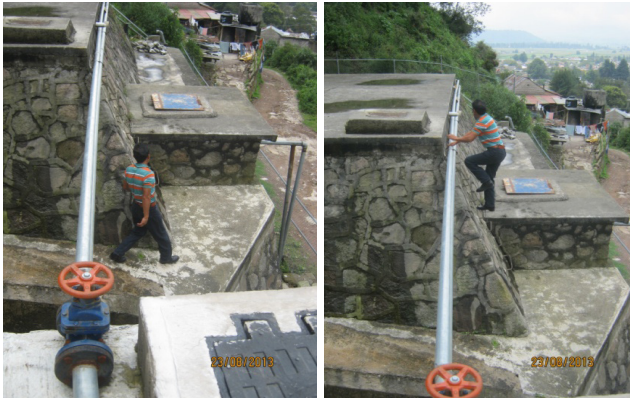
Fotografía 4. Válvula de distribución y caja de agua
