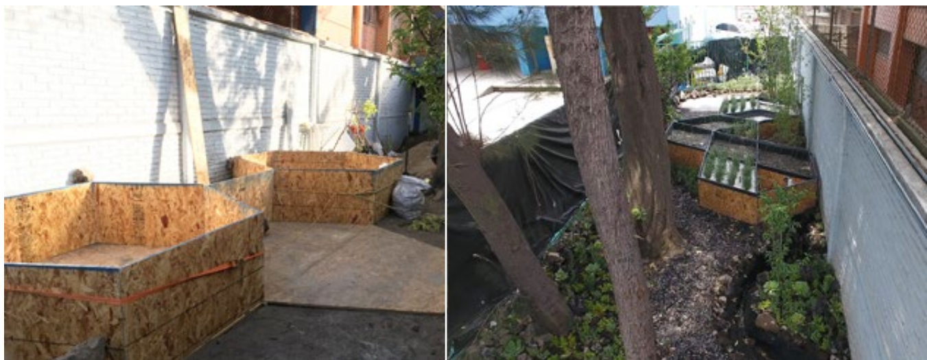
Figura 4. Construcción, instalación y arranque del sistema de tratamiento mediante humedales artificiales.
