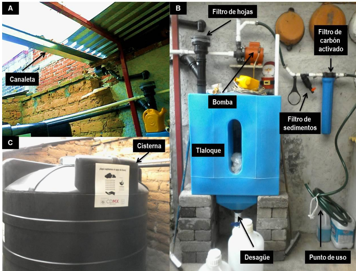
Figura 17 Sistema de captación de agua de lluvia observado en campo. A sistema de canaletas, B Filtro de hojas, Tlaloque, filtro de sedimentos, filtro de carbón activado y punto de uso, C cisterna.
