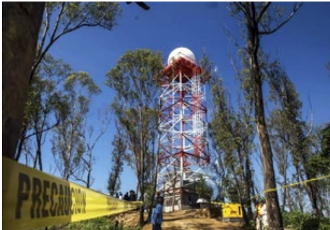
Figura 4. El radar meteorológico de la CDMX visto desde la base de su torre.
