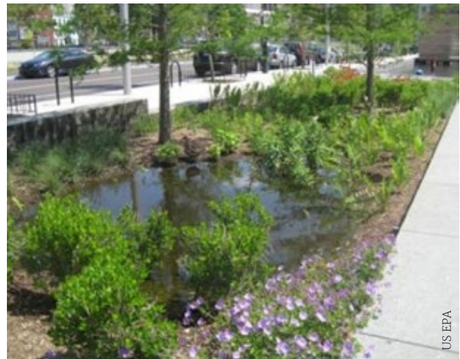
Figura 1. Sistema de biorretención.
