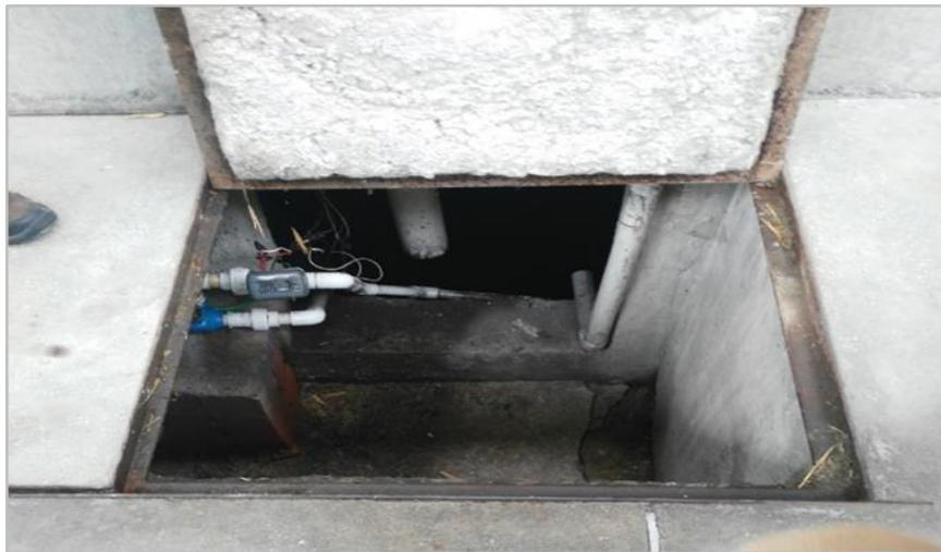
**Figura 8. Cisterna de almacenamiento del agua de lluvia, ubicada en el interior del auditorio "Galileo Galilei". Fuente: Elaboración propia.**
