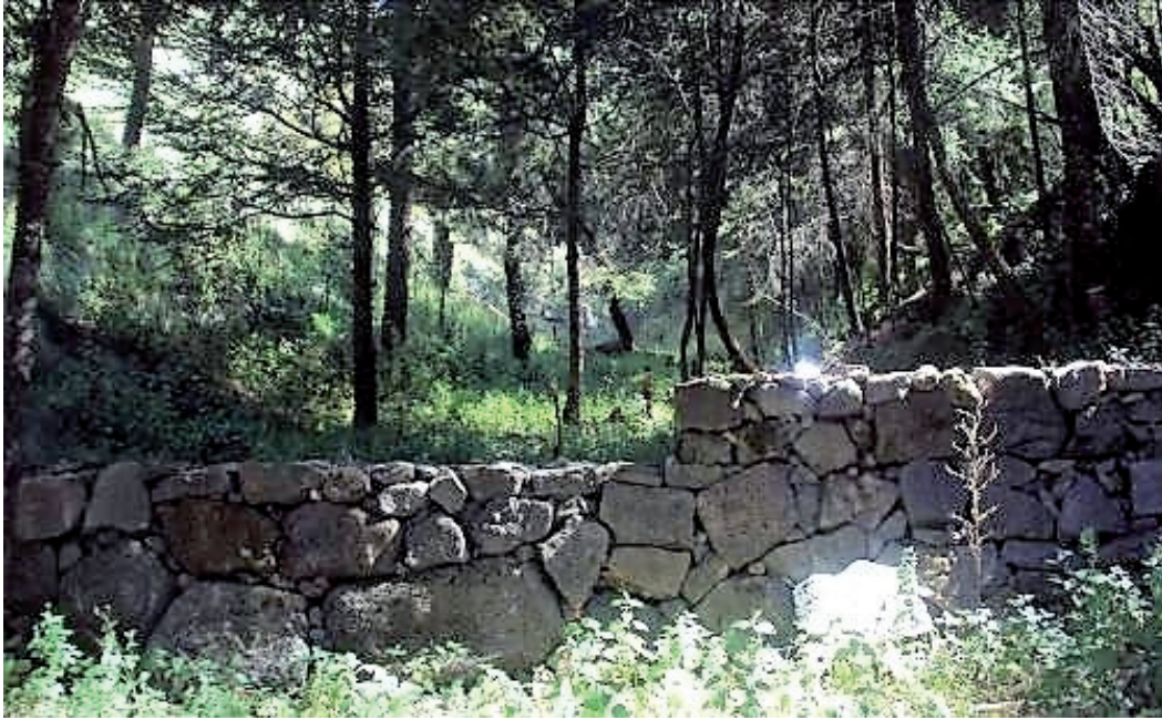
Figura 3. Presa de piedra acomodada en el Ejido de Tequexquihuac. Figure 3. Arranged stone dam in Ejido de Tequexquihuac.
