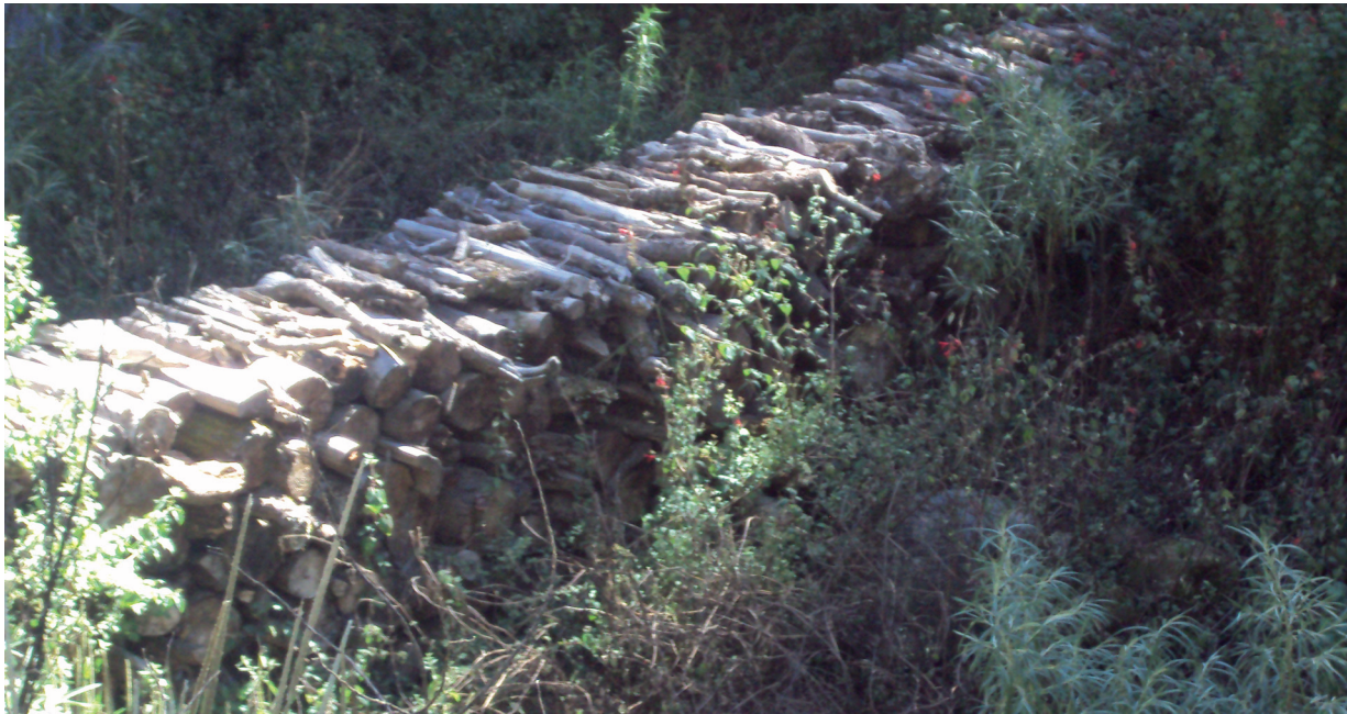
Figura 2. Presa de ramas en el Ejido de Tequexquahuac. Figure 2. Branch dams in Ejido de Tequexquahuac.
