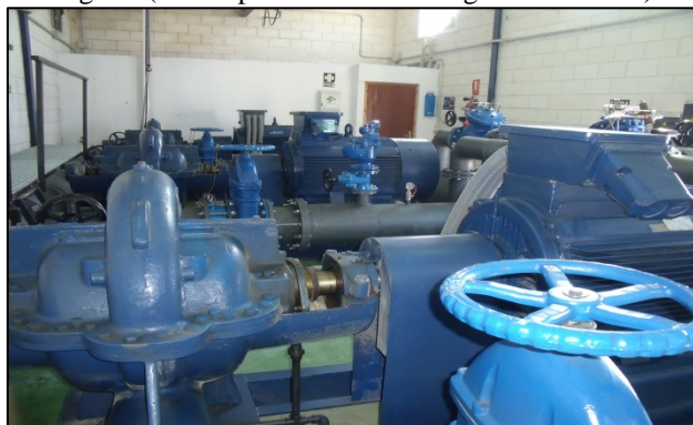
Imagen 4. Estación de bombeo bajo el embalse de Moaire. Comunidad de Regantes de la Zona II del Trasvase Tajo-Segura. (municipio de Blanca – Región de Murcia)
