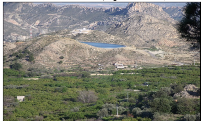
Imagen 6. Embalse para la modernización del regadío de la Huerta de Ricote (Región de Murcia)
