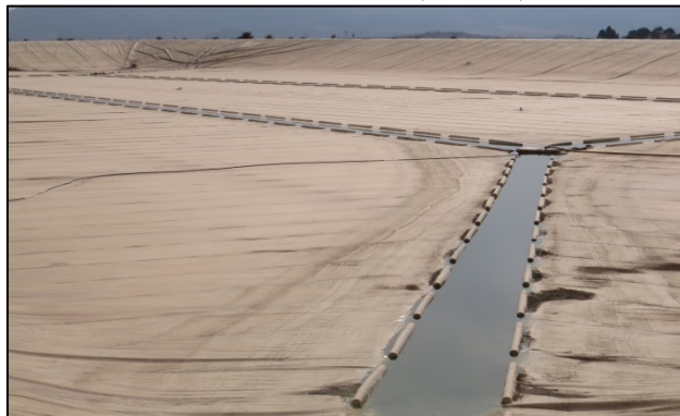
Imagen 8. Embalse cubierto para evitar la evaporación y el desarrollo de algas en la Comunidad de Regantes de Huércal-Overa Norte (Almería)
