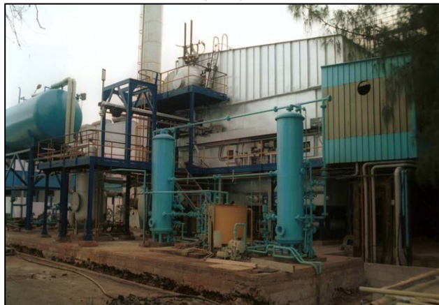
Figura 3. Planta desalinizadora multflash-dual de Arrecife (1964)
