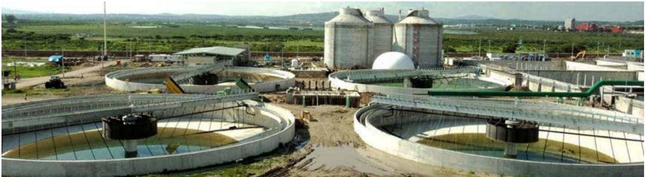
Figura 1. Planta de tratamiento de aguas residuales El Ahogado, con capacidad de tratamiento de 2 250 litros por segundo, localizada en Guadalajara, Jalisco
