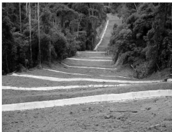
Fig. 39. Estabilización de pendientes.
