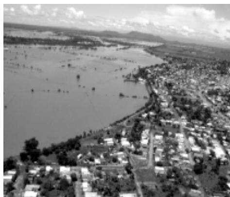
Fig. 43. Bordo longitudinal sobre el río Santiago , Nay.
