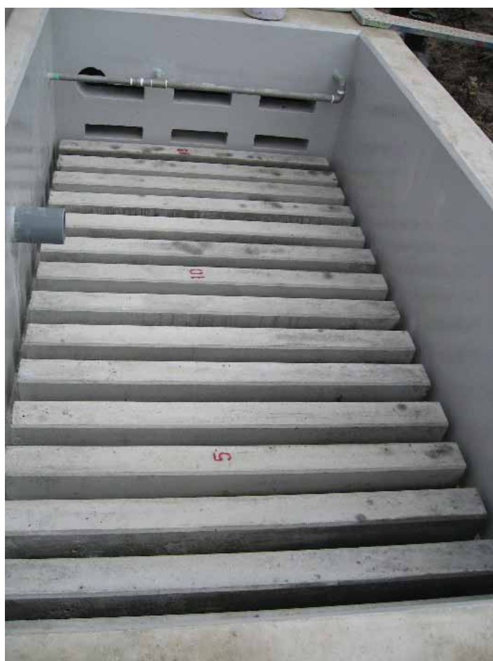
Fotografía No. 37 Trabe de soporte instalada
