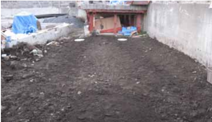
Fotografía No. 7 Vista de zanja de filtración terminada
