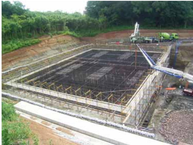
Fotografía No. 23 Armado de acero de refuerzo en cimentación
