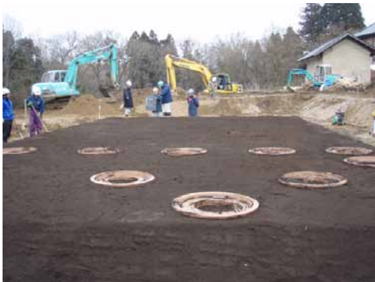
Fotografía No. 46 Colocación de cubierta vegetal
