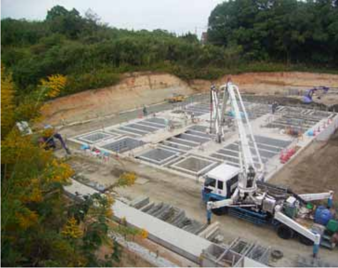
Fotografía No. 28 Pruebas de hermeticidad de tanques con agua
