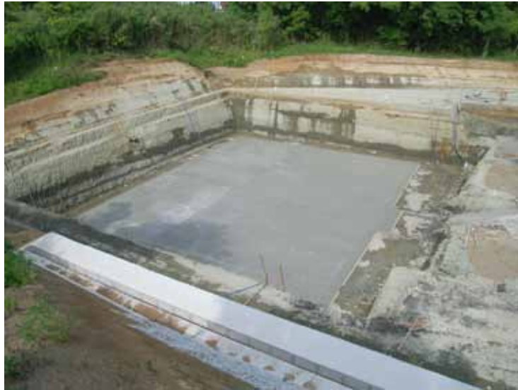
Fotografía No. 22 Excavación para desplante
