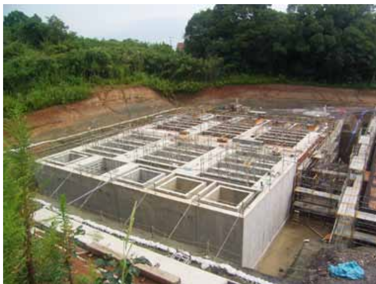
Fotografía No. 27 Colado de concreto en losas
