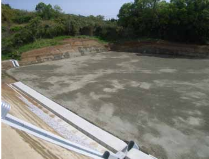
Fotografía No. 19 Trazo y nivelación de obra
