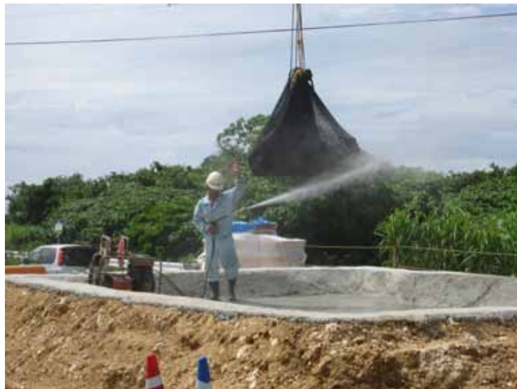
Fotografía No. 40 Limpieza de grava
