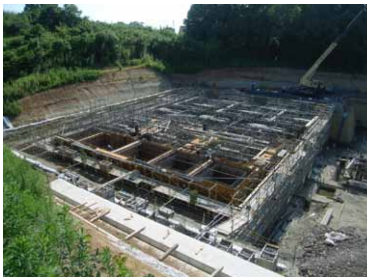
Fotografía No. 24 Armado de acero de refuerzo en muros
