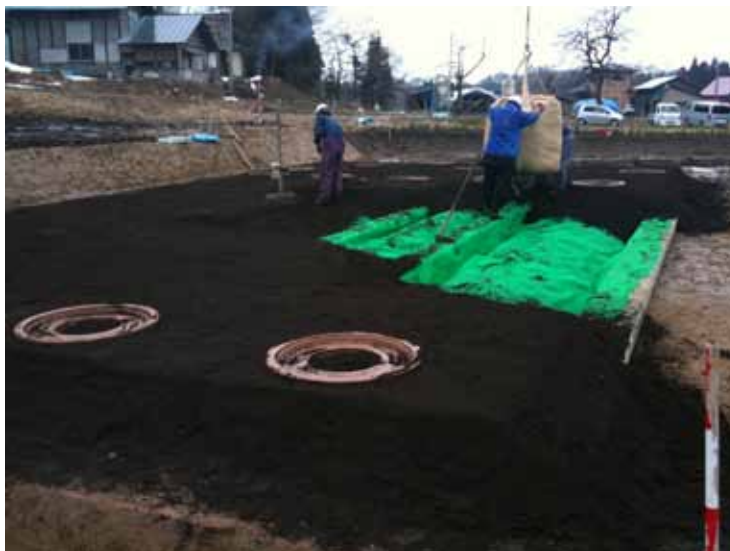
Fotografía No. 49 Comprobación de espesor de tierra
