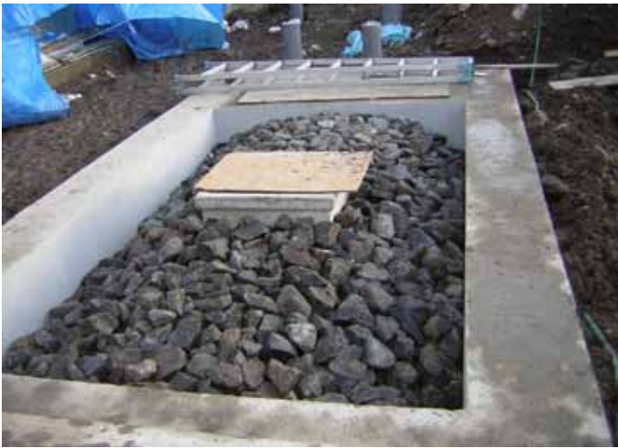
Fotografía No. 13 Grava en el lecho superior
