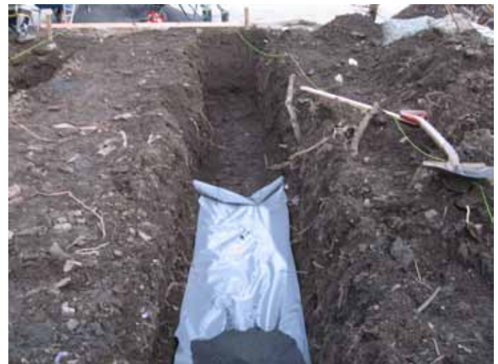
Fotografía No. 2 Instalación de película plástica
