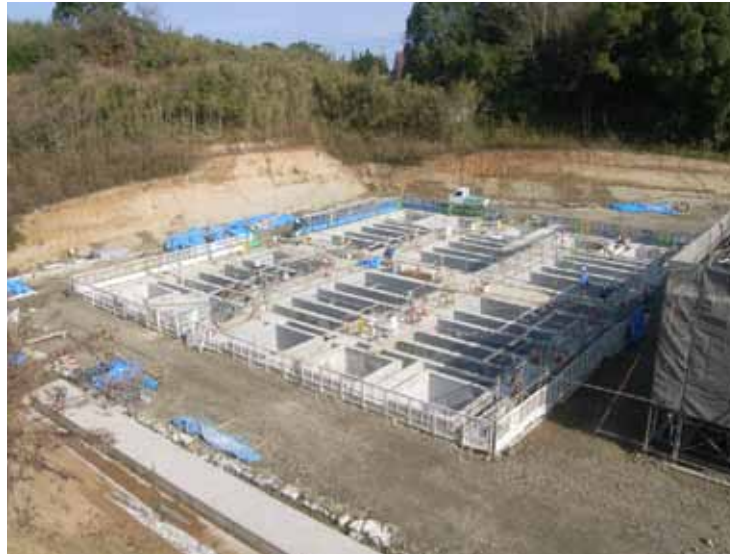
Fotografía No. 38 Distribución de grava de contacto
