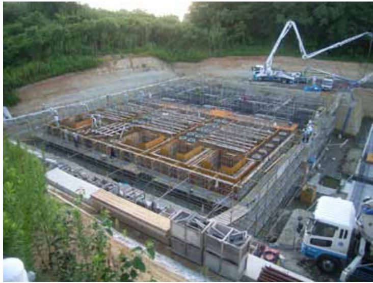
Fotografía No. 25 Armado de acero de refuerzo en muros intermedios
