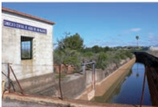
Figura V-3. Toma del río Mijares (izquierda), y Canal a cielo abierto (derecha).
