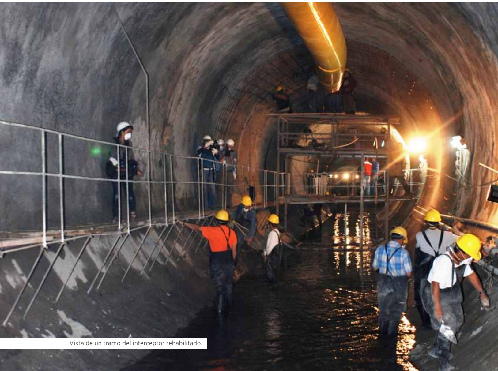
Elevadores utilizados en la rehabilitación.
