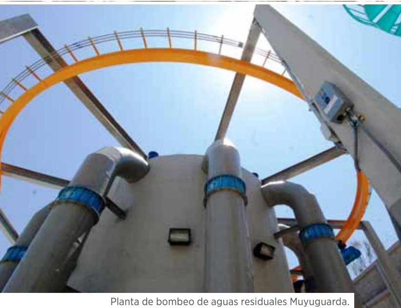
Vista aérea de la planta de bombeo de aguas residuales del Gran Canal km. 11+600.
