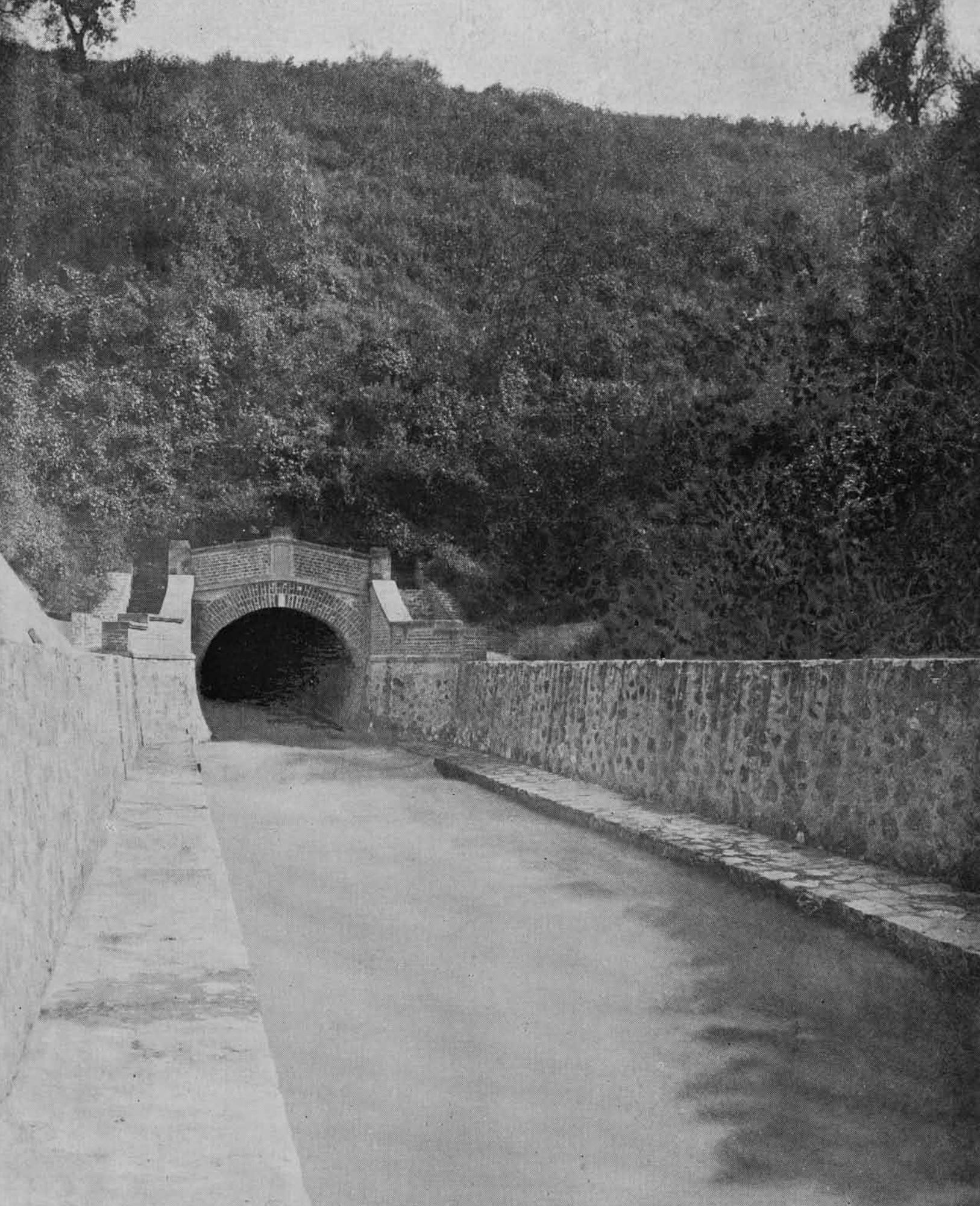
Desagüe del Valle: Boca de salida del túnel Tequixquiac.
