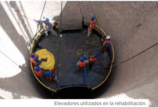
Preparación de cimbra.
