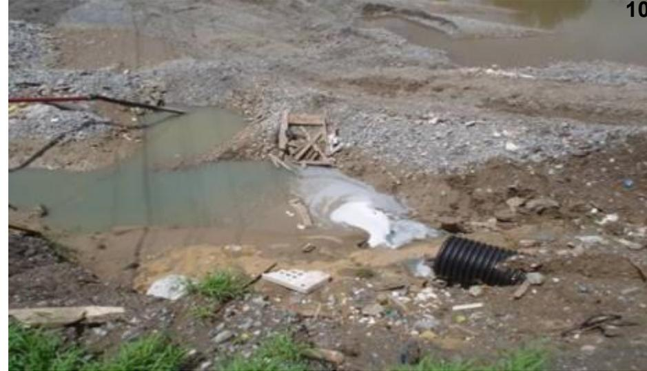
Tuberías dañadas en Colector Obispo y Sanitario Sur de 24" de diámetro, a la altura del puente Maldonado y calle Zinc respectivamente.
