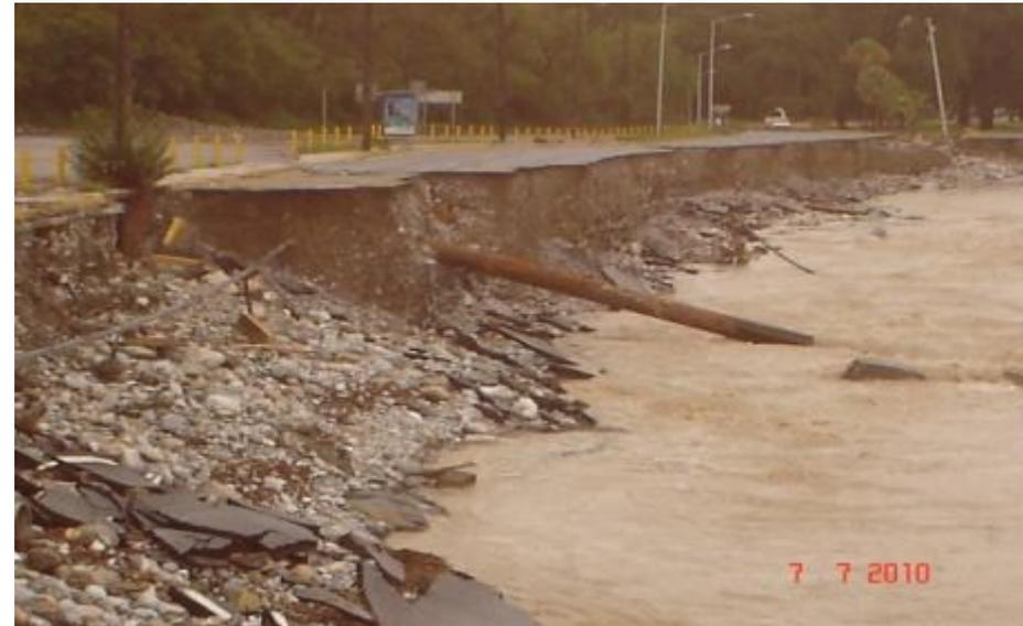
Entre el puente Mira Valle y puente Gonzalitos en la margen derecha del río Santa Catarina se destruyó tubería de acero de 24" y cuerpos de vialidad, longitud aproximada 224 mts
