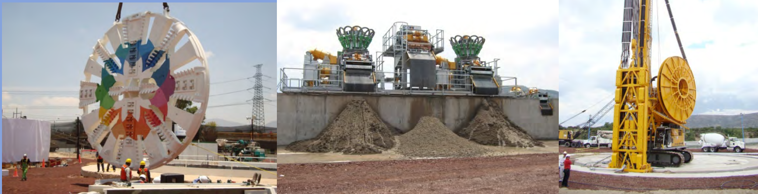
Maquinaria de alta tecnología para cavar el túnel y las lumbreras
