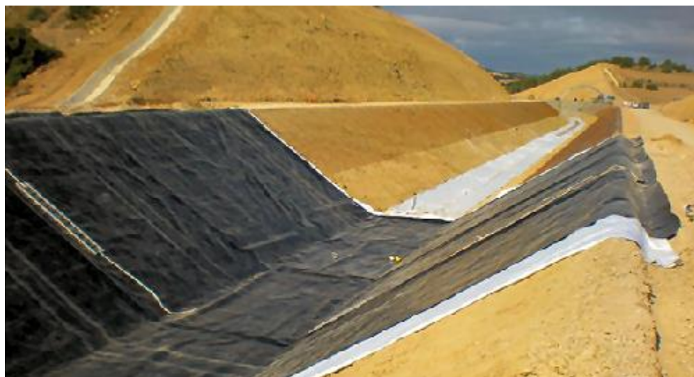
Imagen 1. Impermeabilización de un canal con geotextil y geomembrana de PVC.
