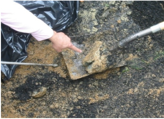
a) Colecta manual de bolas de lodos.
