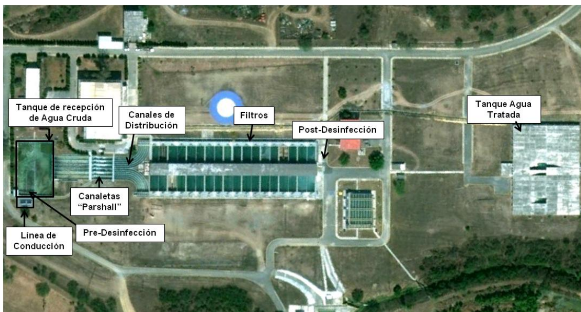
Figura No. 5. Vista aérea de la planta potabilizadora "San Roque".
