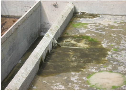
a) Presencia de algas y sedimento arcilloso sobre la antracita.
