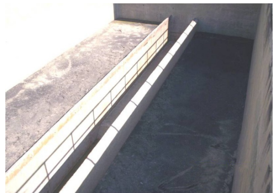
b) Diferencias entre los niveles de las camas filtrantes.
