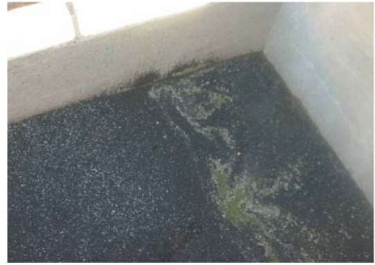
b) Antracita contaminada con arena en la superficie.
