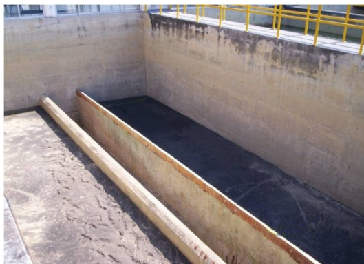
a) Capa de arena sobre la antracita.
