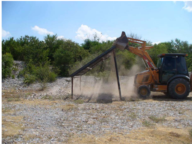
Figura 11. Cribado de sustrato para pantano de flujo subsuperficial.
