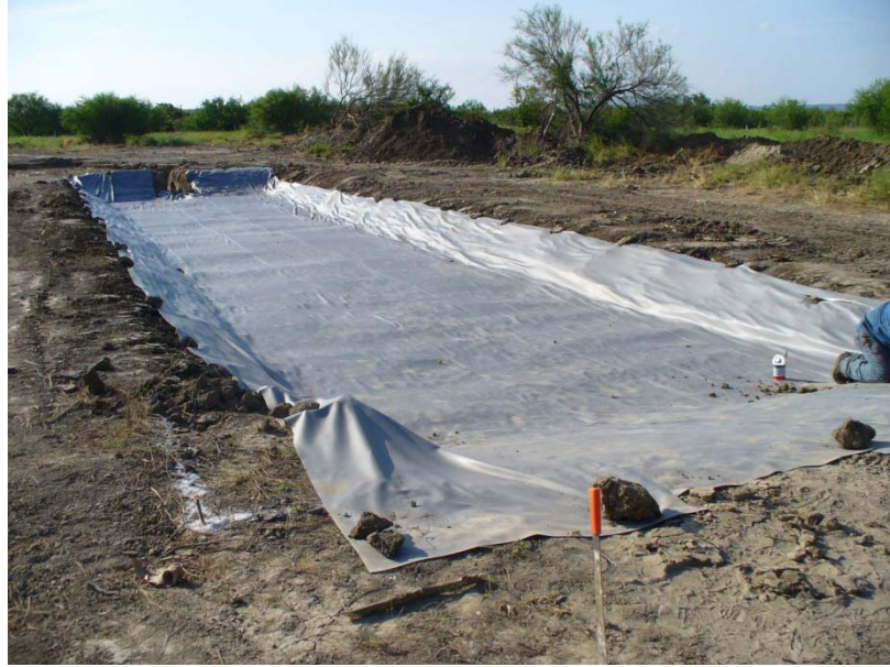
Figura 10. Impermeabilización con geomembrana de los pantanos.
