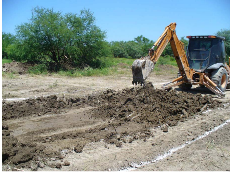
Figura 8. Excavación de pantanos construidos.
