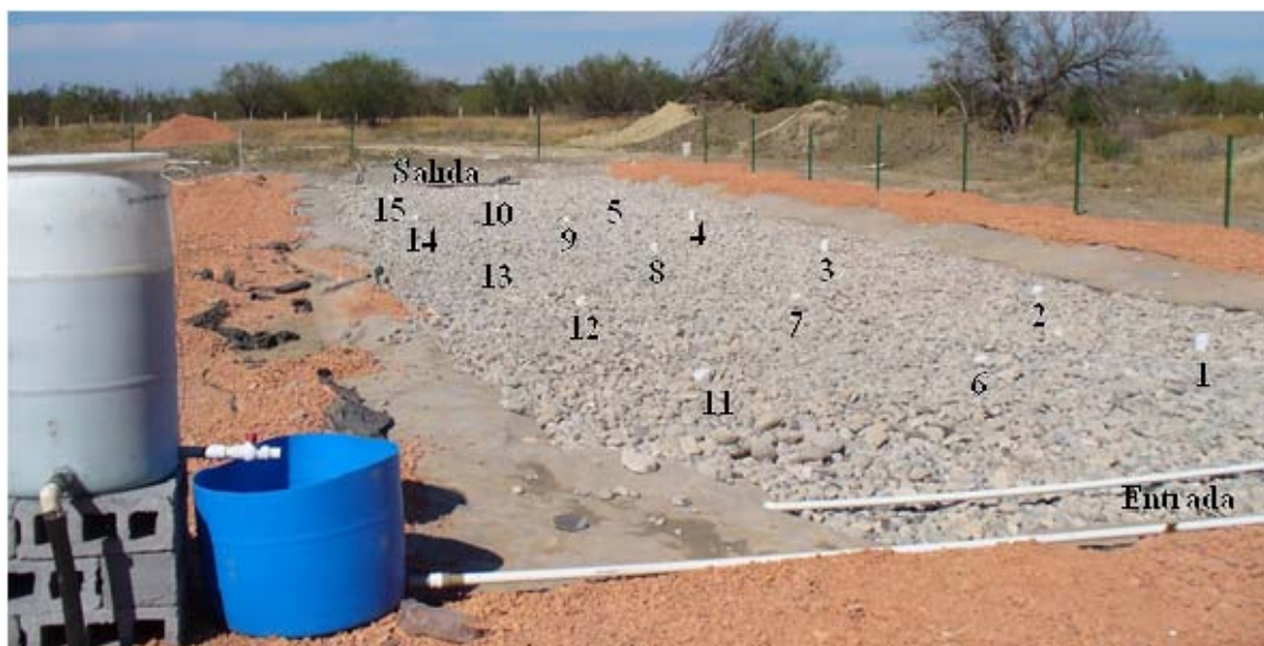
Figura 1. Vista general y puntos de muestreo del pantano de flujo subsuperficial.
