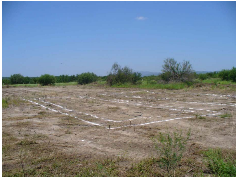
Figura 7. Marcado en terreno para excavación.
