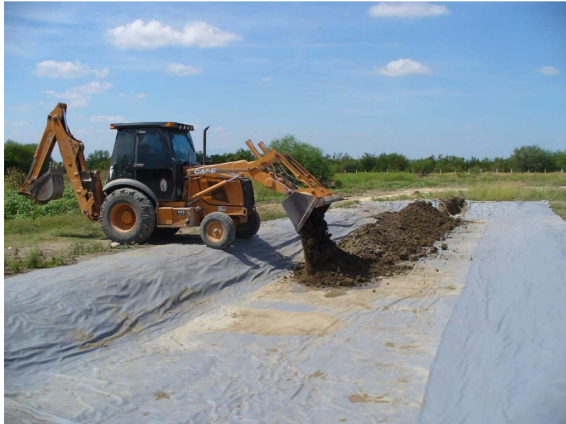
Figura 13. Colocación de sustrato en pantano de flujo superficial.
