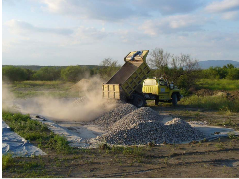
Figura 12. Proceso de rellenado de pantano de flujo subsuperficial.
