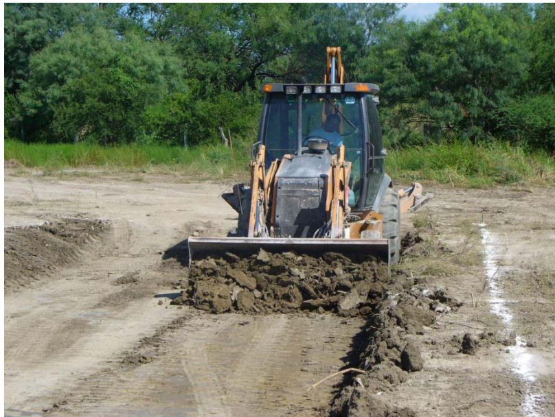
Figura 9. Nivelación del piso de los pantanos construidos.
