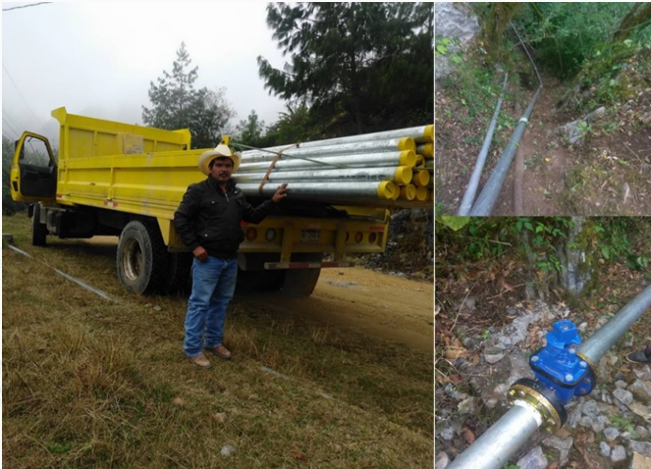
Figura 28. Entrega-recepción de material, 12 de febrero del 2018 y avance de obra 28 de abril 2018.
