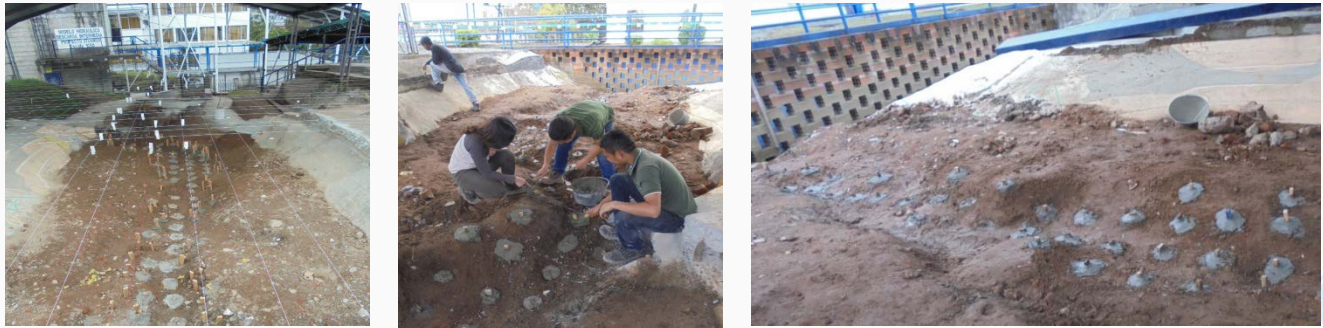
Figura 3. Izquierda: Mallas utilizadas para el proceso de verificación de la topografía. Centro y Derecha: proceso de estacado para detalle de topografía.
