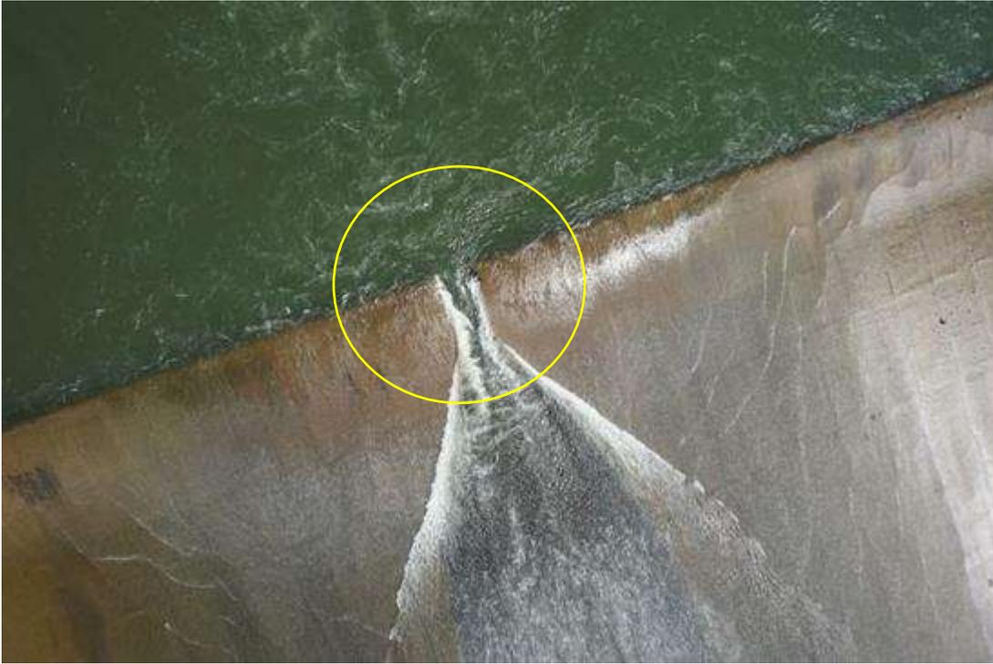
Figura 5.48 Detalle del desgaste del vertedor en la zona de convergencia de flujos
