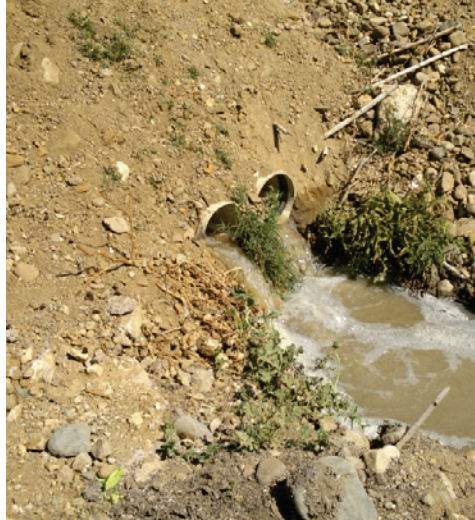
Imagen 3. Descarga de aguas residuales crudas a un cuerpo receptor (Río Atoyac, Oaxaca)
