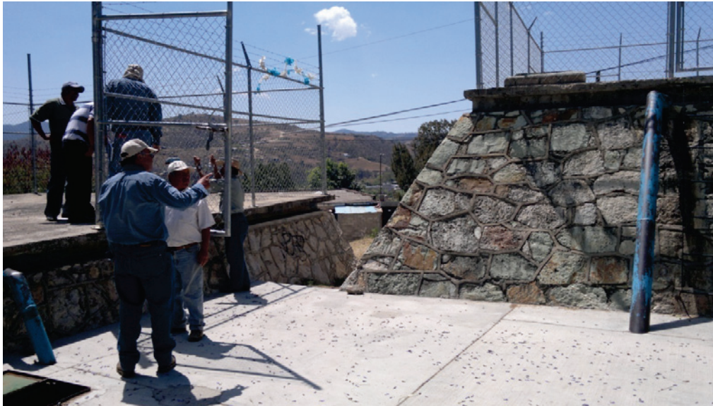
Imagen 1. Trabajos de campo. Inspección y levantamiento a los principales elementos de la infraestructura hidráulica
