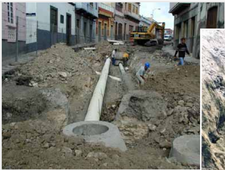
Redes de Alcantarillado
