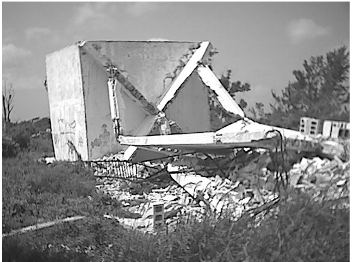
Figura 10. Tanque de almacenamiento derrumbado por los efectos del huracán Isidore en Yobaín, Yucatán
