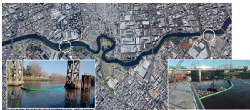
Figura N° 2. Barreras en el tramo Puente Alsina - Puente Bosch
