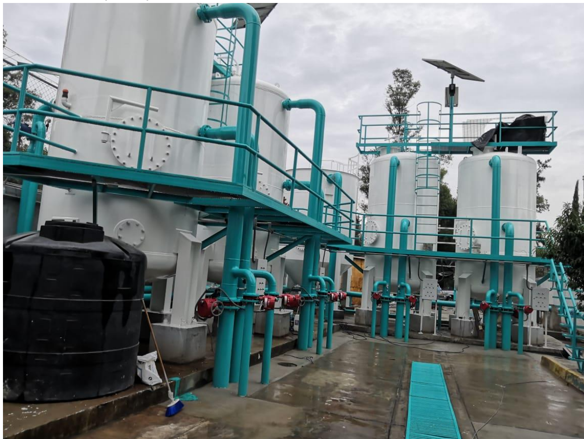
Planta potabilizadora "la Viga 4" Jennifer Bañuelos.
