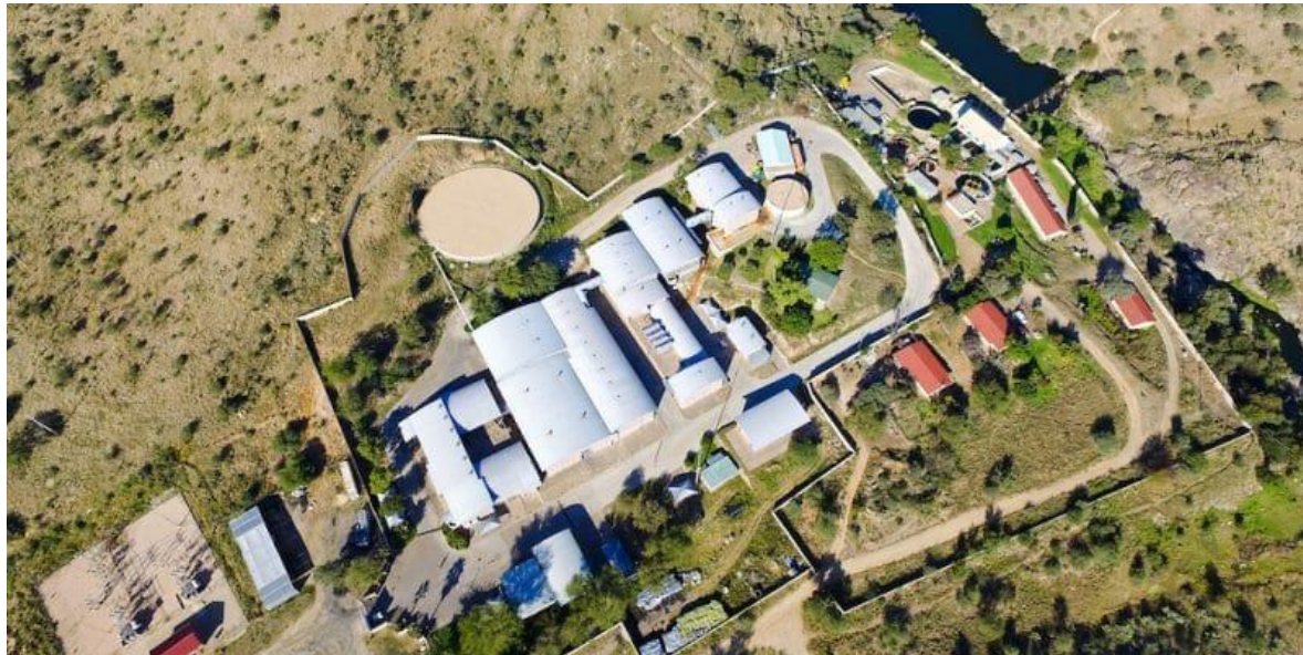
Vista aérea de la planta potabilizadora de Windhoek, Namibia.
