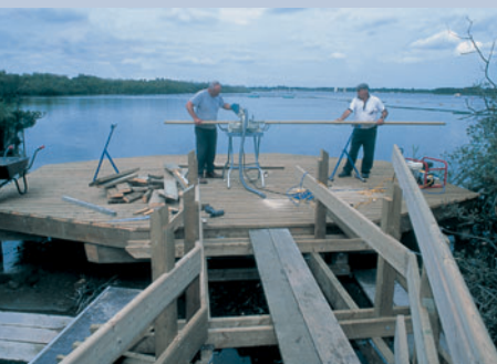
Construcción de la senda de madera Herons Carr en los Broads
