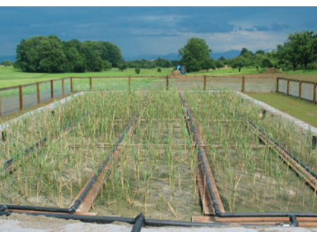
Humedal artificial, recién plantado
