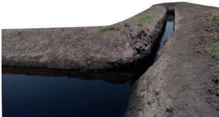
Apertura de la zanja y escalón
