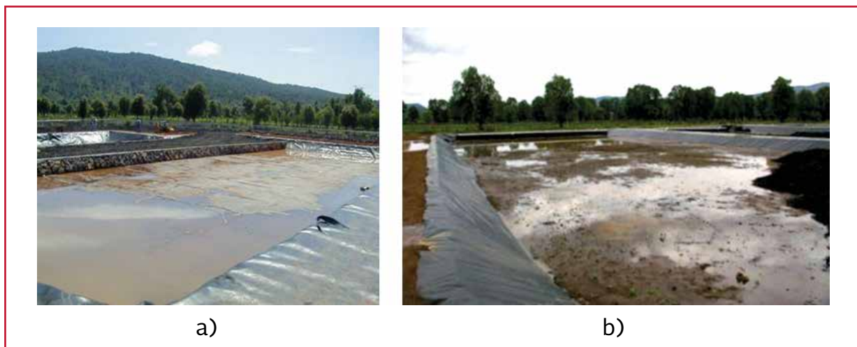
Ilustración A.4 a) Pruebas de infiltración, b) llenado de los estanques
