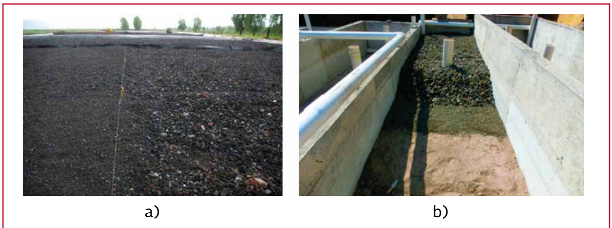
Ilustración 2.32 Colocación del medio filtrante. a) grava con diámetro de 1 a 1.5 cm colocada sobre grava con diámetros de 2 a 3 cm, b) Colocación de diversas capas de grava (arcilla en el fondo, y grava de 2 a 5 cm en la superficie)
