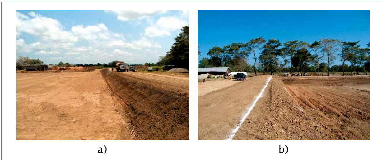
Ilustración 2.16 Construcción de taludes mediante arcilla
