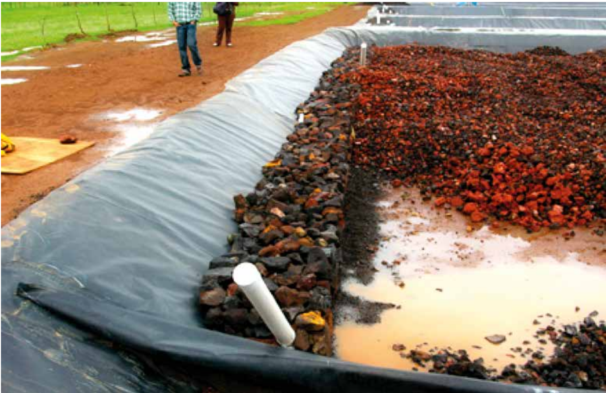
Ilustración 2.34 Colocación del cabezal de distribución de caudal
