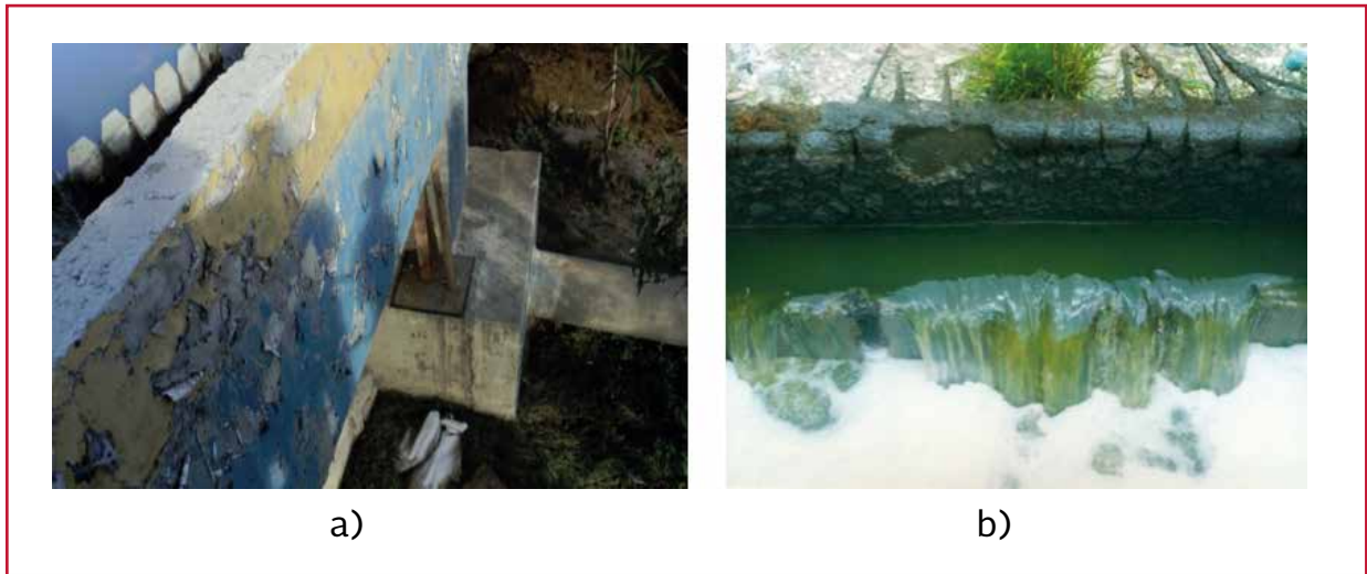
Ilustración 2.9 Cementos de baja calidad. a) Paredes de un registro de llegada, b) Vertedor rectangular
