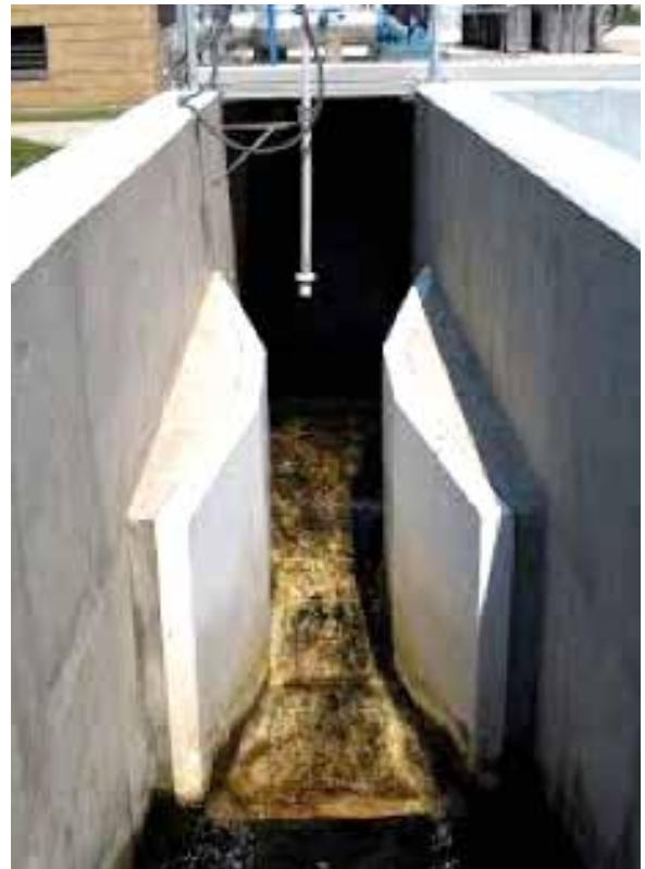
Ilustración 2.13 Aforador Parshall
