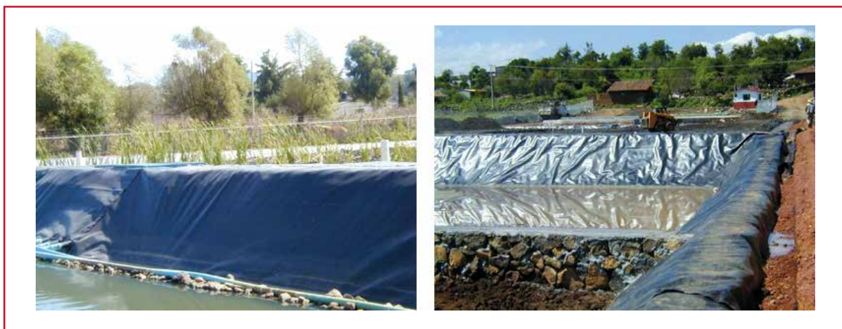
Ilustración 2.18 Construcción de bordos mediante geomembrana anclada
