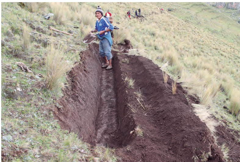
Figura 4. Construcción de zanjas de infiltración
