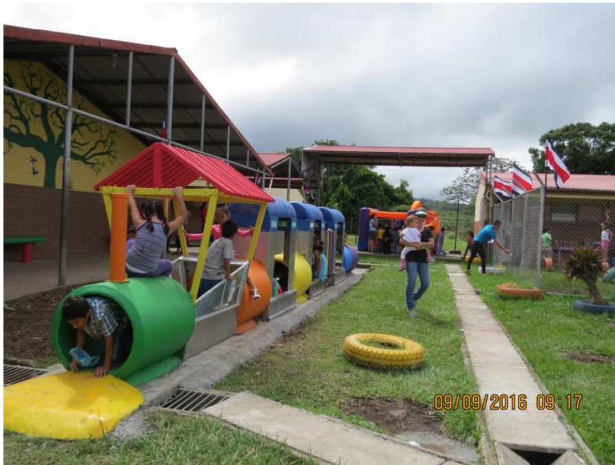
Figura 6.14 Construcción parquecito con materiales de residuos del ICE (Escuela El Carmen, 2016).
