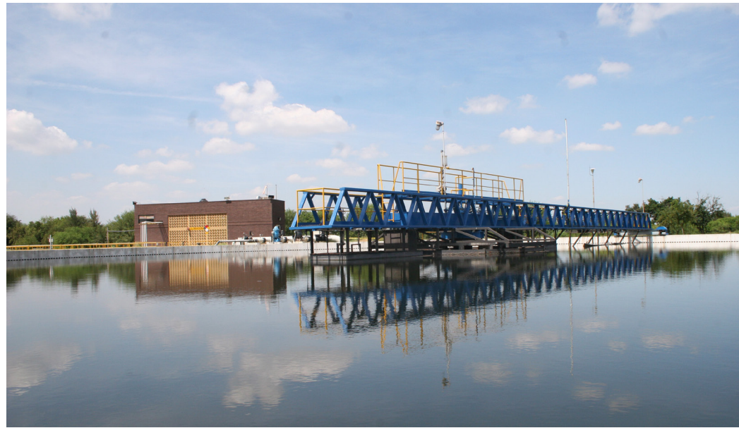
Planta de tratamiento de aguas residuales Noreste. Fuente: Cortesía SADM.
