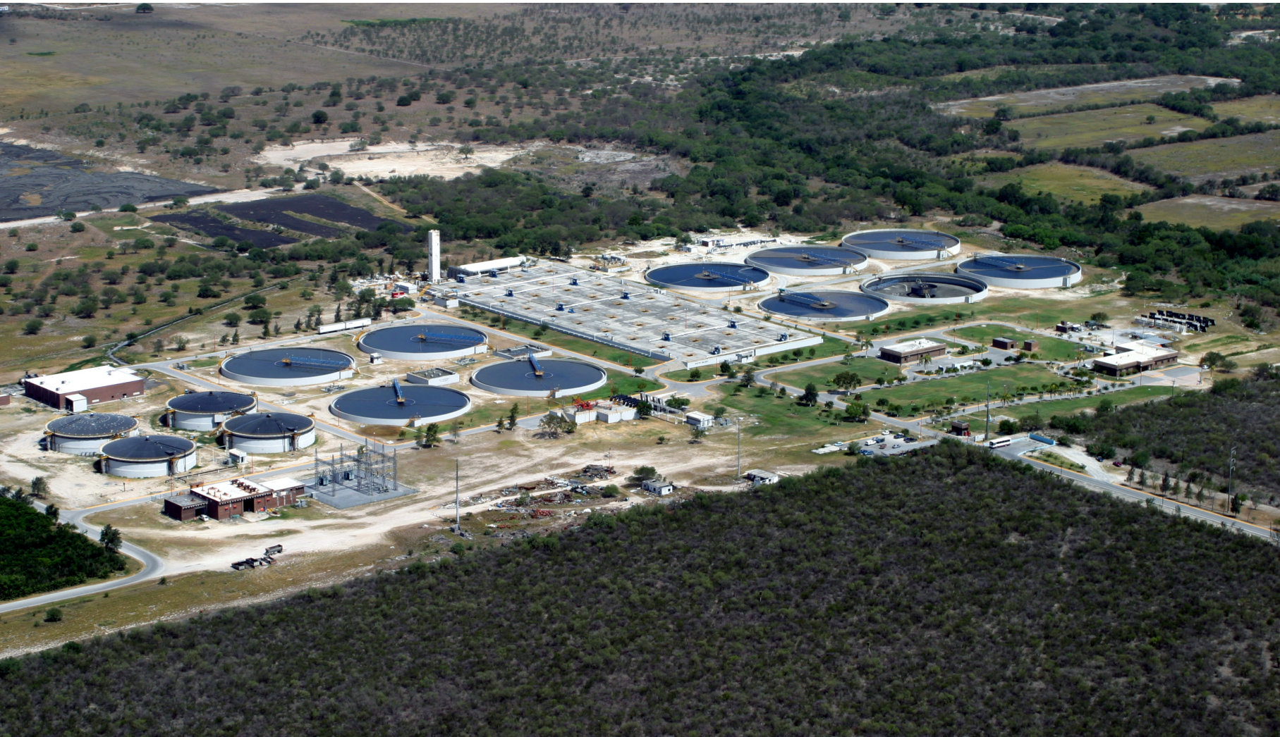
Planta de tratamiento de aguas residuales Dulces Nombres. Fuente: Cortesía SADM.
