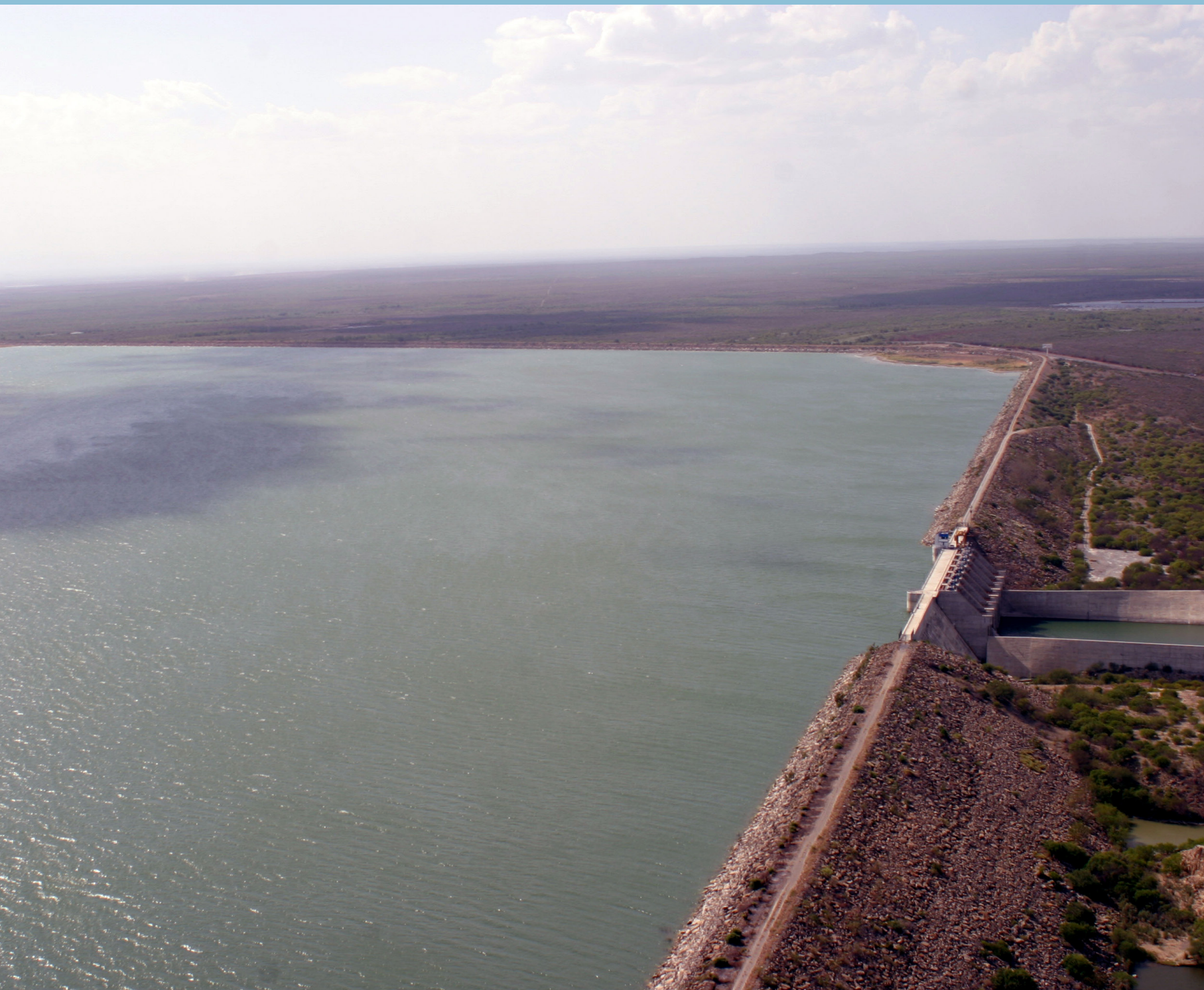
Vista de la presa El Cuchillo. Fuente: Cortesía SADM.
