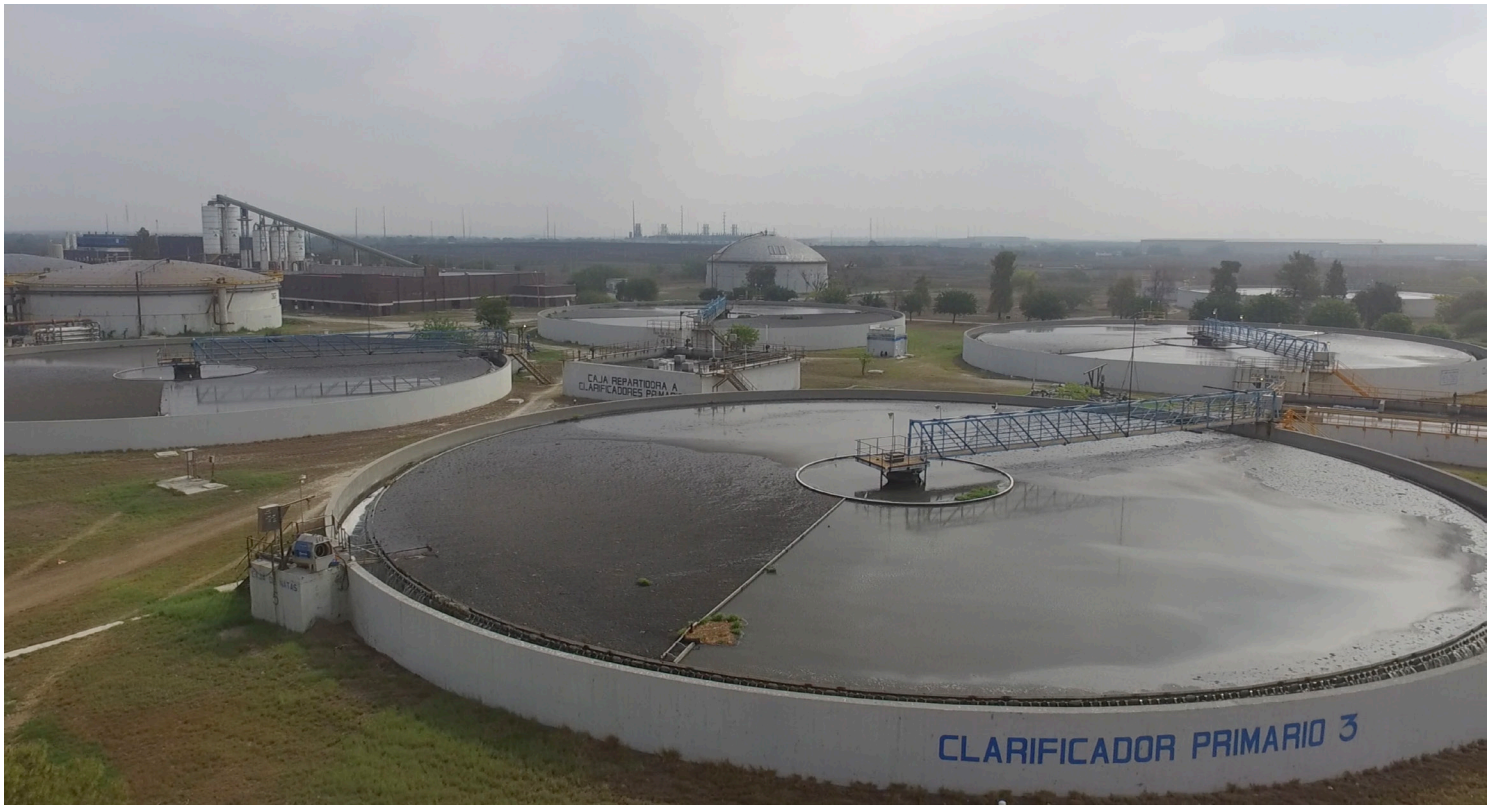
Planta de tratamiento de aguas residuales Dulces Nombres, parte del proyecto Monterrey IV. Fuente: Cortesía SADM.
