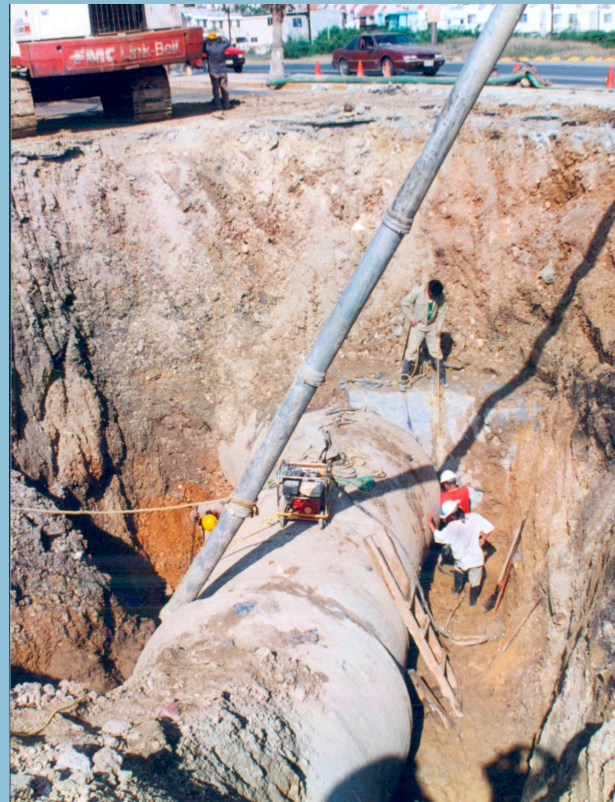
Construcción de anillo de transferencia. Fuente: Cortesía de SADM.
