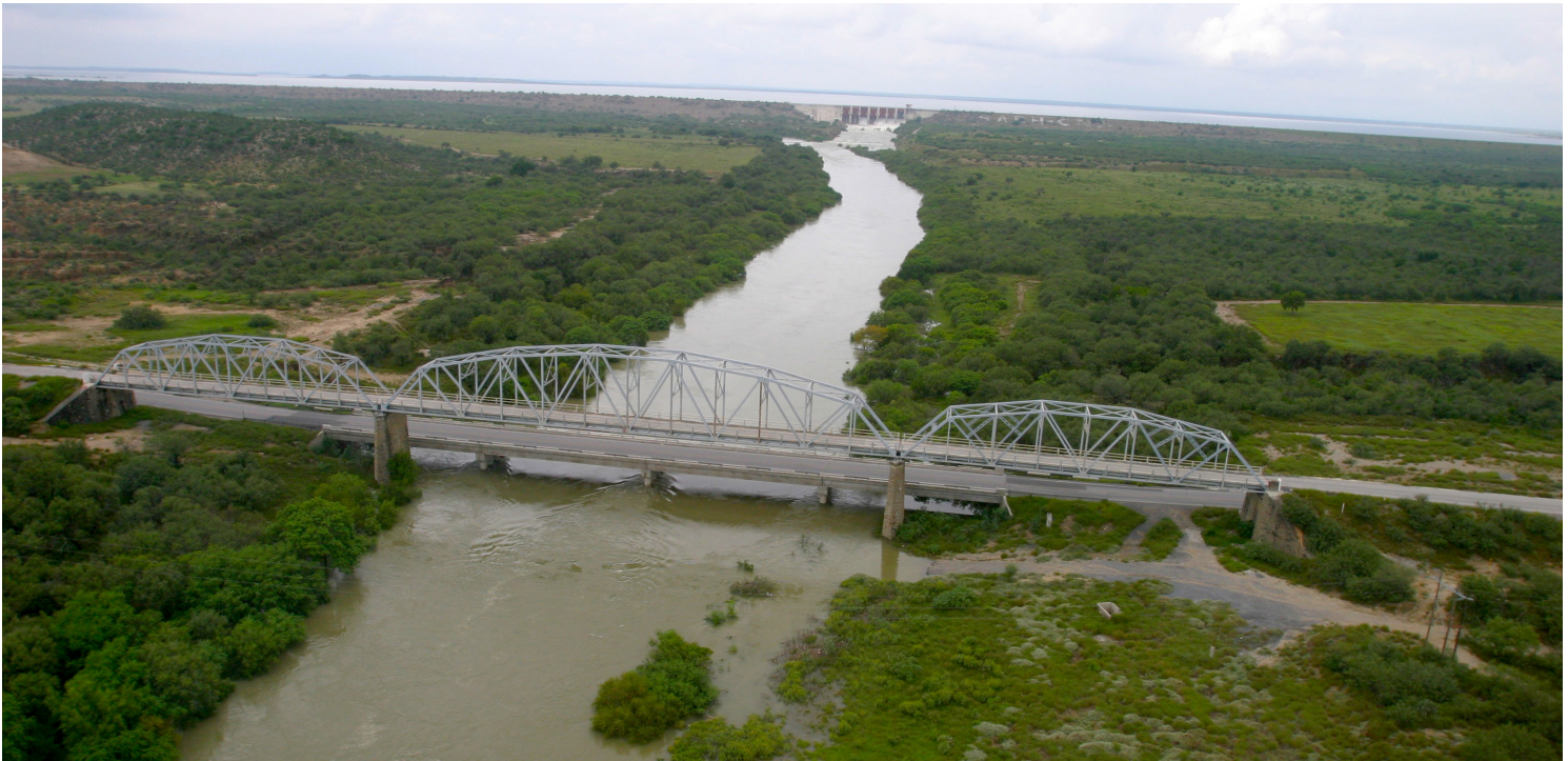
Vista del río San Juan. Fuente: Cortesía de SADM.
