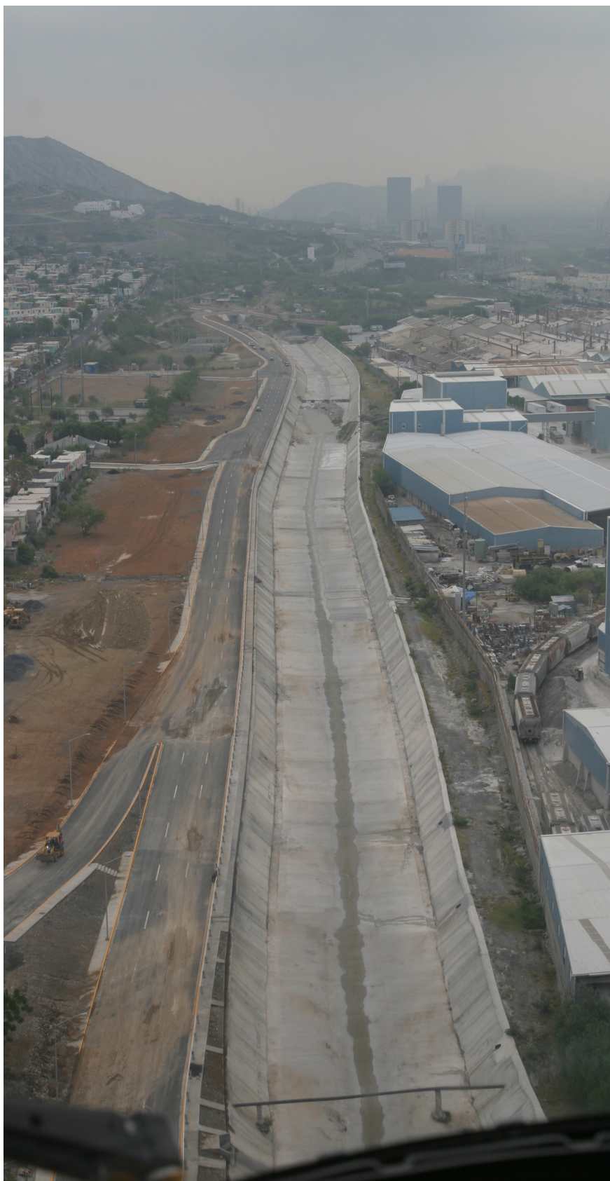
Canalización del arroyo El Obispo. Fuente: Cortesía SADM.
