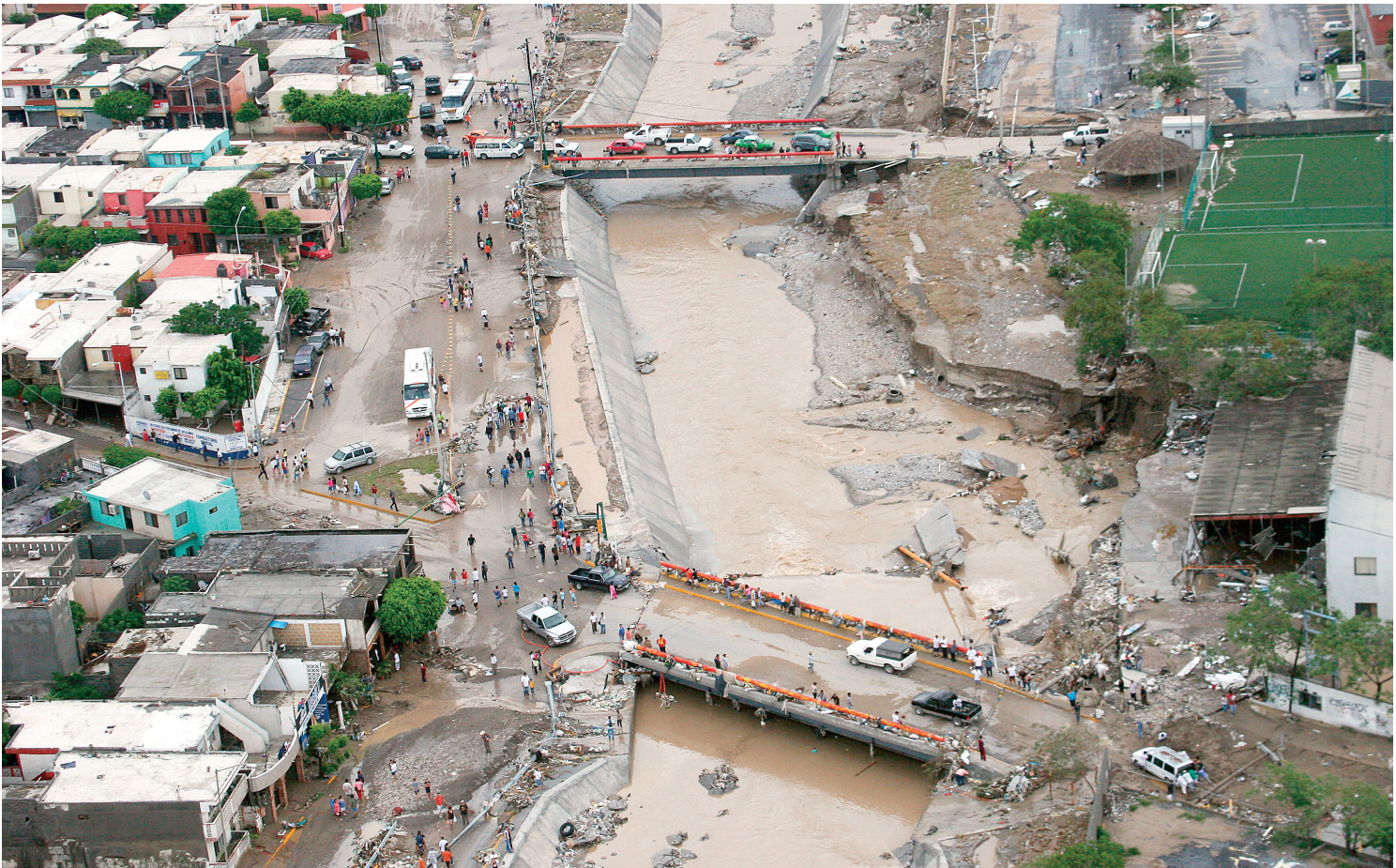
Daños provocados por la tormenta tropical Álex, 2010. Fuente: Fototeca Milenio (Paco Cantú).
