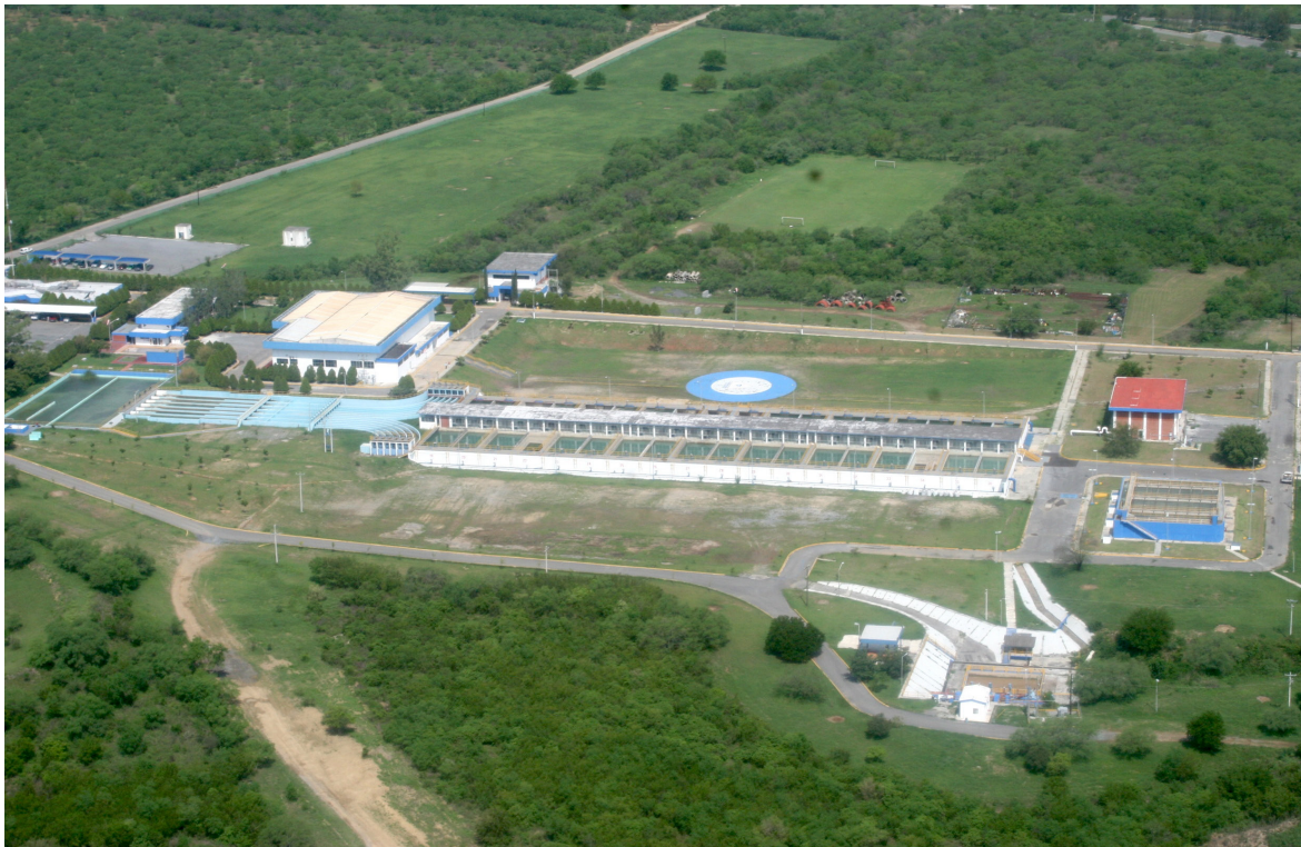
Planta potabilizadora San Roque. Fuente: Cortesía SADM.
