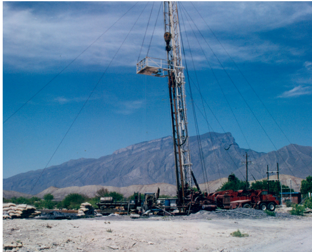
Perforación de pozo para agua potable. Fuente: Cortesía SADM.
