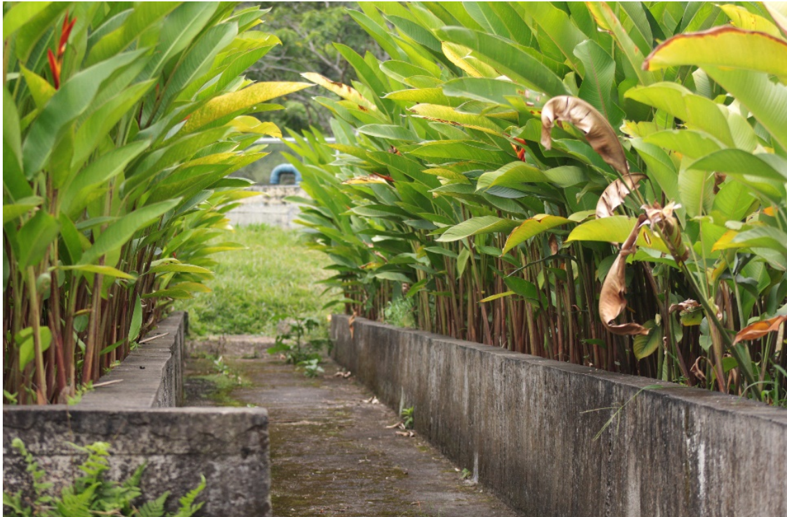
Figura 15. Zona de humedales en la última etapa de tratamiento en la PTARD de la Asociación de usuarios de acueducto y alcantarillado de la localidad de La Vorágine-Asovorágine
