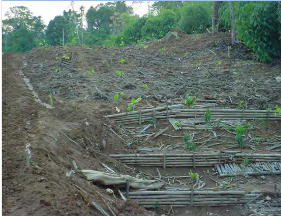
Figura 8-1. Reforestación y estaquillados de madera para la recuperación de laderas en la región Selva
