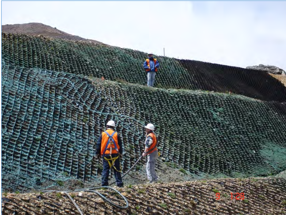
Figura 8-3. Aplicación de mezcla de hidrosiembra en la región Andina
