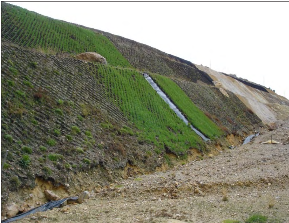
Figura 8-4. Resultados de hidrosebrado en la región Andina
