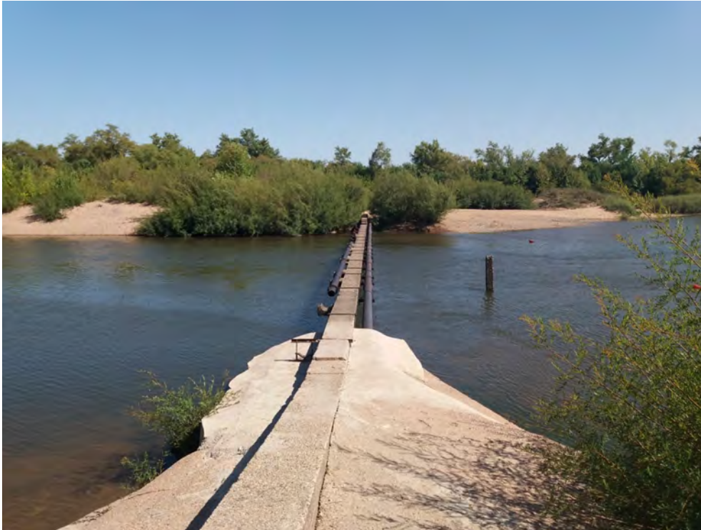
Figura 9-3. Pasarela sobre el río Santa Lucía. Ejemplo de punto de monitoreo de transporte por fondo utilizando el muestreador US-BL84
