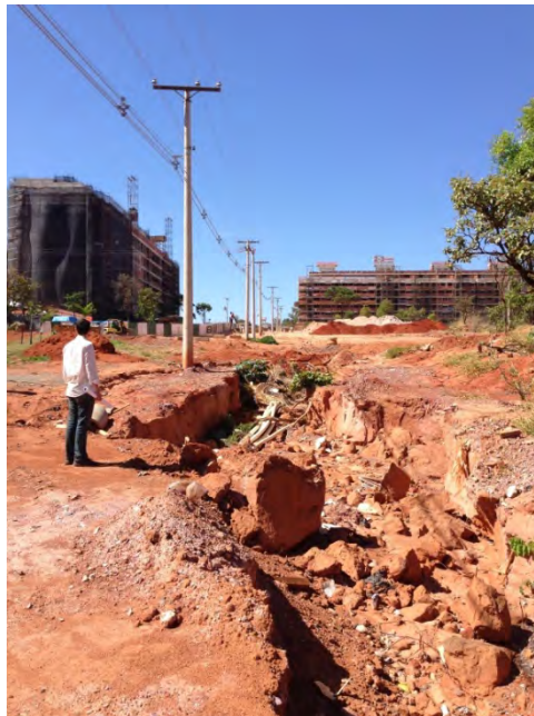
Figura 2-13. Cárcava en el Condominio Noroeste (Brasília-DF).
