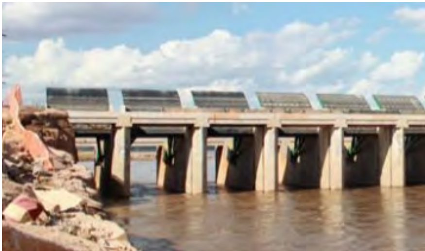
Figura 2-10. Compuertas de la presa de Santo Antonio, al nivel del lecho
