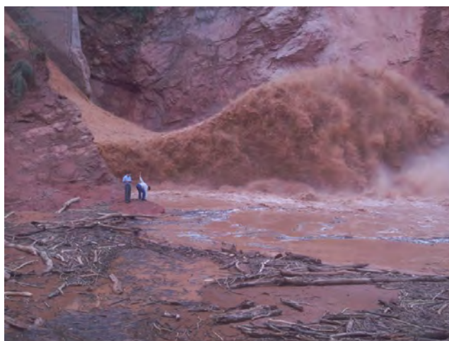
Figura 1-7. Dique Itiyuro – Detalle del vertedero con flujo cargado de sedimentos
