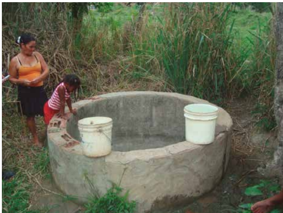
FIGURA 3 Pozo construido en Buracão
