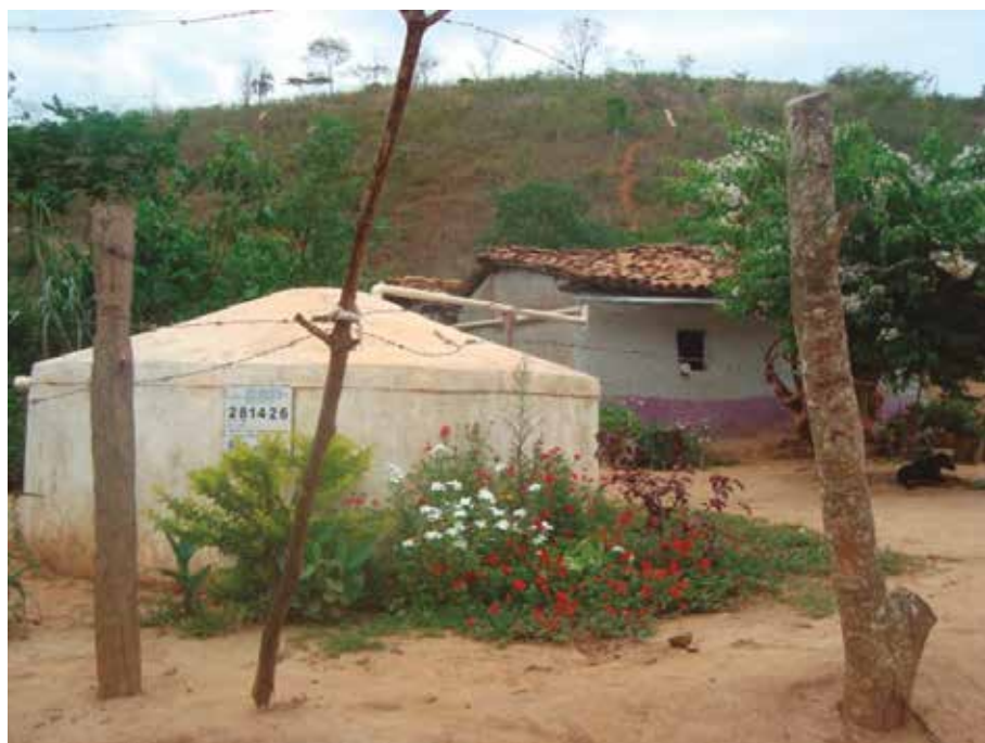
FIGURA 2 Cisterna construida en la comunidad de Buracão
