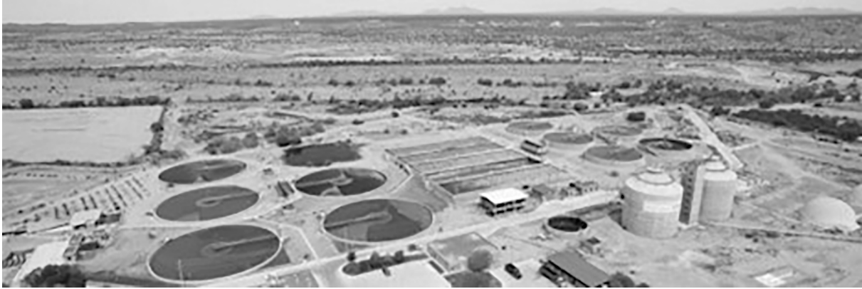
Figura 5.6. Vista de la PTAR Hermosillo en 2016
