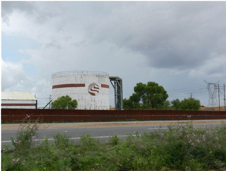
Figura 5.5 Estación de rebombeo de agua Los Patos
