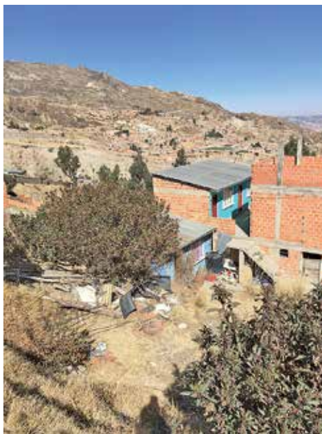
Foto 2: Estrategia de recuperación de agua de lluvia, como alternativa a la red de distribución de agua potable. (S. Hardy, 2019).
