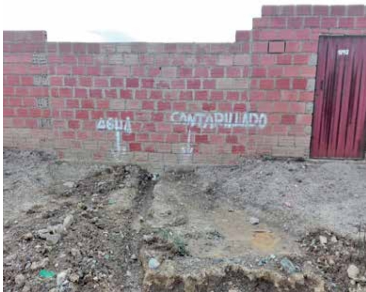
Foto 2: Distrito 7, municipio de El Alto. Instalación de agua y alcantarillado en la Urbanización Nueva Florida. (V.H. Perales, 2018).
