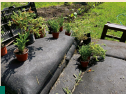
Vegetación colocada en las coronas de los bordos.
