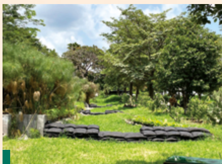
Implementación de bordos con geocostales en los sitios destinados para un mayor caudal de regulación.
