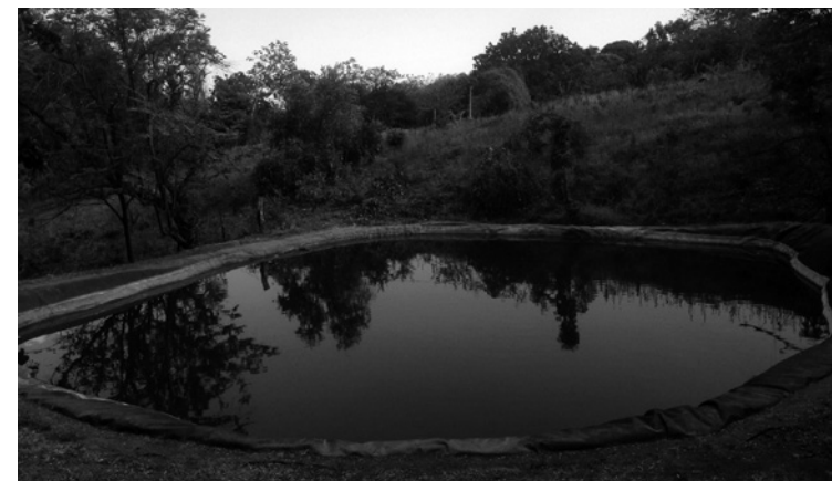
Figura 1. Reservorio de agua de lluvia, Nicoya, Guanacaste
