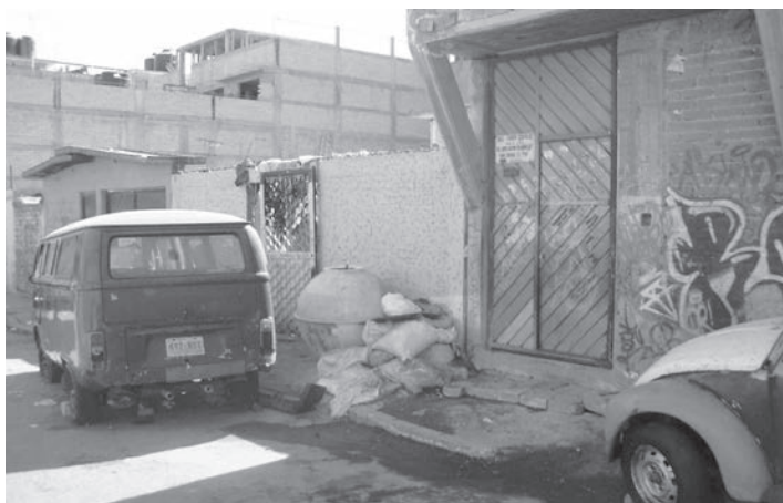
FOTOGRAFÍA 3.4. FACHADA DE UNA VIVIENDA EN CALLE PLAYA GRANDE, COL. LA POLVORILLA, IZTAPALAPA
