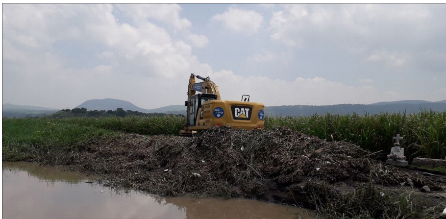
Figura 8. 2. Trabajos de desazolve de canales de la Laguna de Atotonilco (Fuente: J. de Anda-Sánchez, 2021, elaboración propia)
