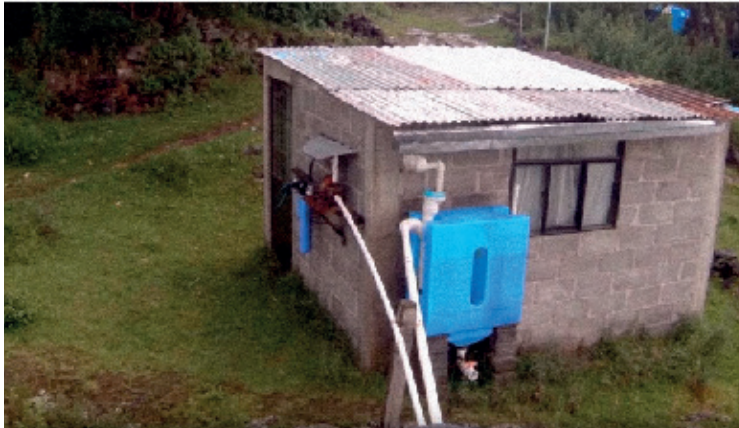
Fig. 13. Sistema familiar de captación de agua de lluvia de "Isla Urbana": el Tlaloque. Fuente: Youtube. Fotografía extraída del vídeo "¡Capta lluvia con ISLA URBANA!"
