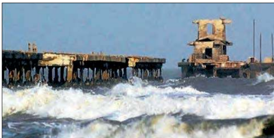
Foto 2. Muelle de Puerto Colombia
