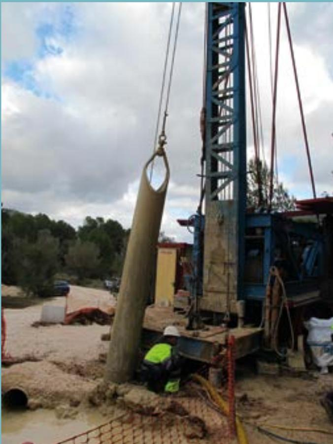
*Detalle de la válvula de cuchara de un sondeo perforado a percusión.
