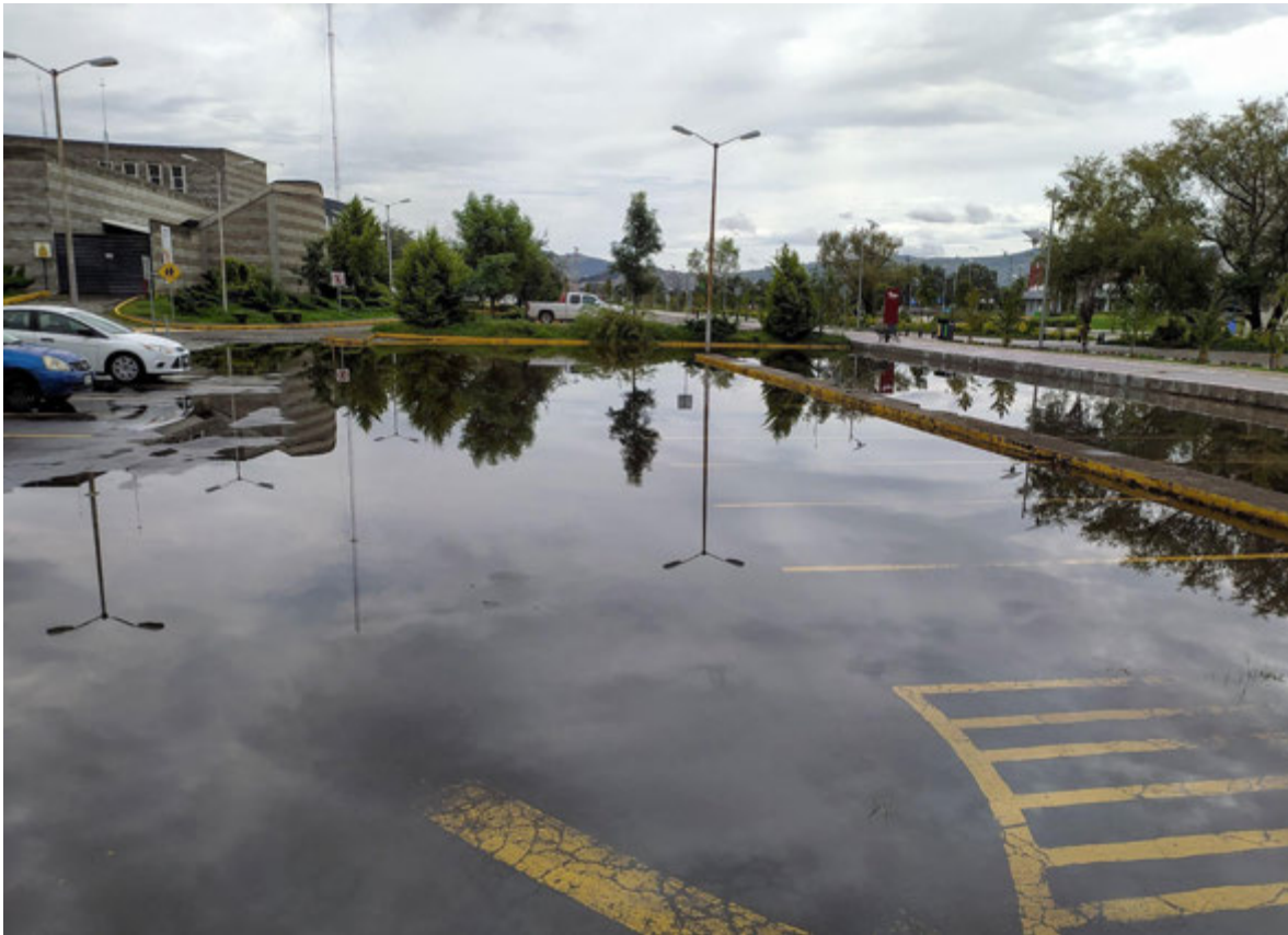
Fig. 6. Estacionamiento situado en la parte más baja del terreno, anegado por la escorrentía proveniente de las vialidades y edificios adyacentes.
