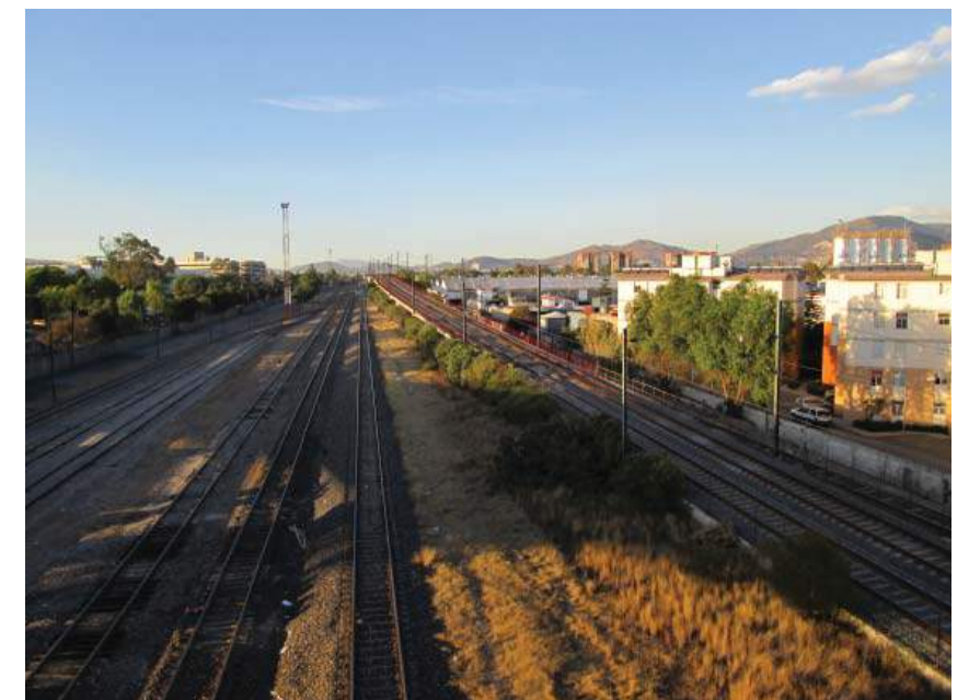
Figura 2.6 Zona industrial de Azcapotzalco. Concentra cerca de un tercio del suelo industrial de la Ciudad de México. Fuente: Casandra Badillo, 2016.
