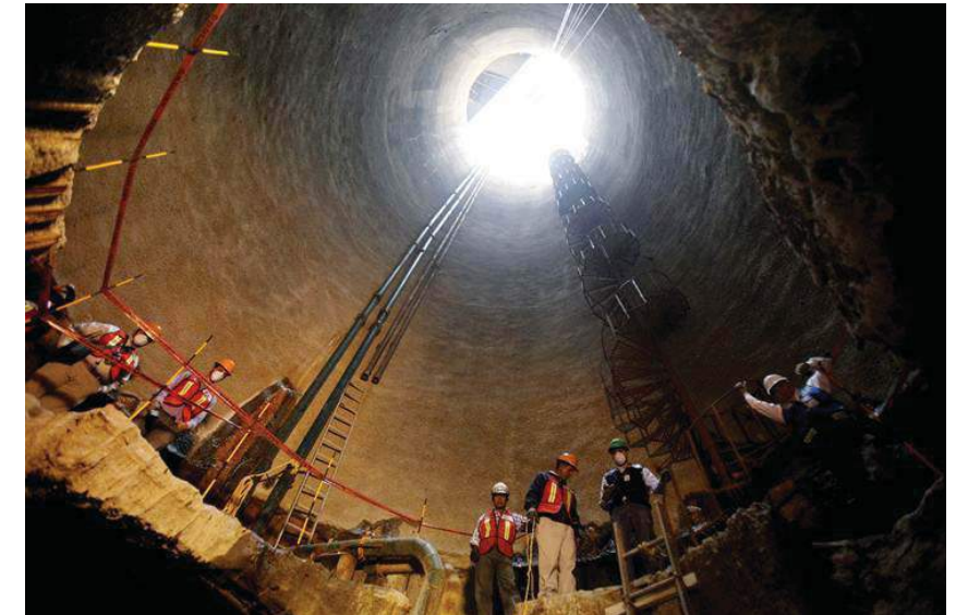
Figura 1.29 Drenaje Profundo. A pesar de las dimensiones colosales de este proyecto de megainfraestructura, no ha logrado dar abasto a las necesidades reales de la Ciudad de México. Fuente: Disponible en: < http://www.eluniversal.com.mx > Acceso en julio, 2015.
