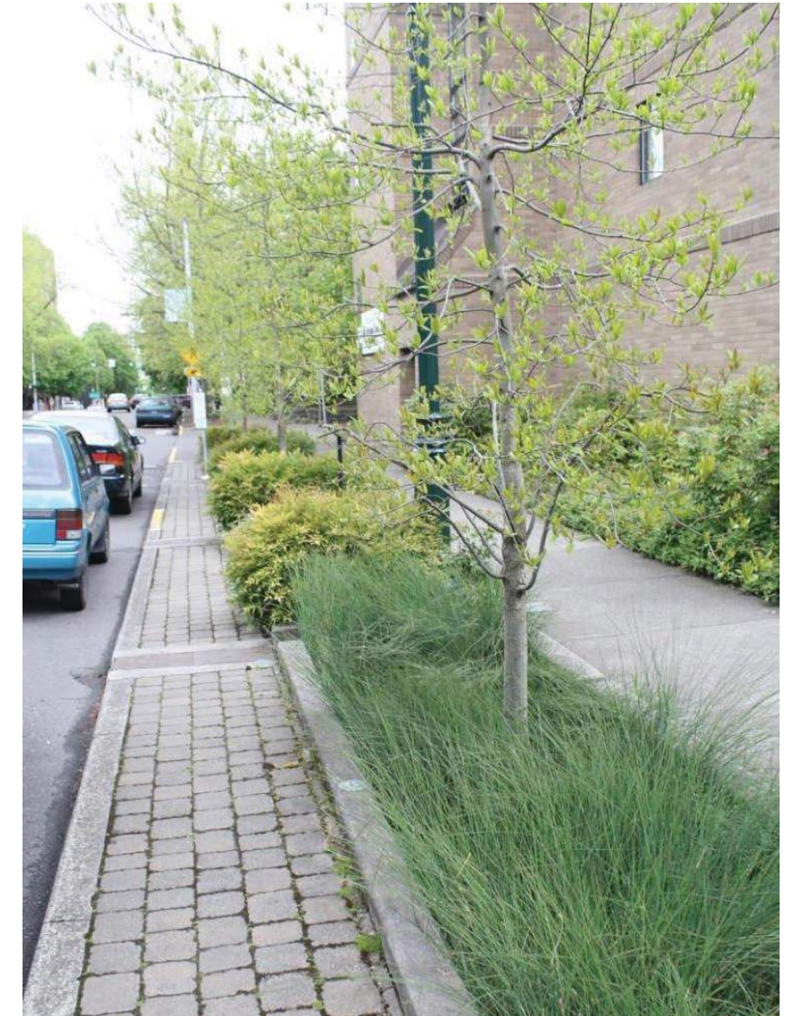
Figura 1.10 Jardín de lluvia en The Southwest 12th Avenue, Portland, Oregon, EE. UU., Fuente: Disponible en: < http://landperspectives.com > Acceso en junio, 2015.
