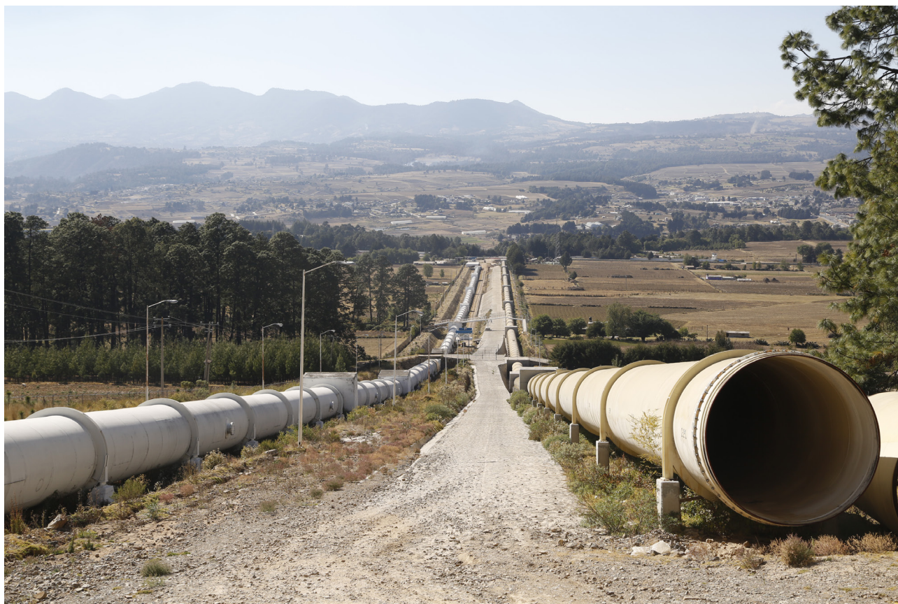
Foto: Sistema Cutzamala, infraestructura hídrica de distribución de agua potable de Ciudad de México y Estado de México | CONAGUA.
