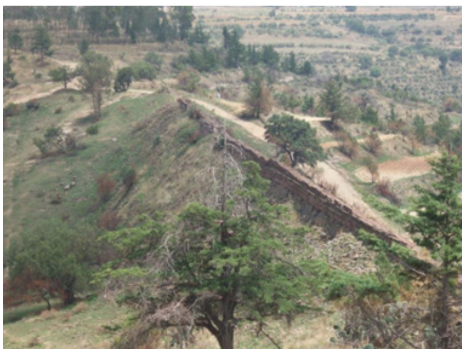
Figura 13. Caño Quebrado, restos de terraplen para el paso de acueducto, San Pablo Ixayoc, Texcoco Edo. Méx. Fotografía Gustavo Coronel Sánchez.
