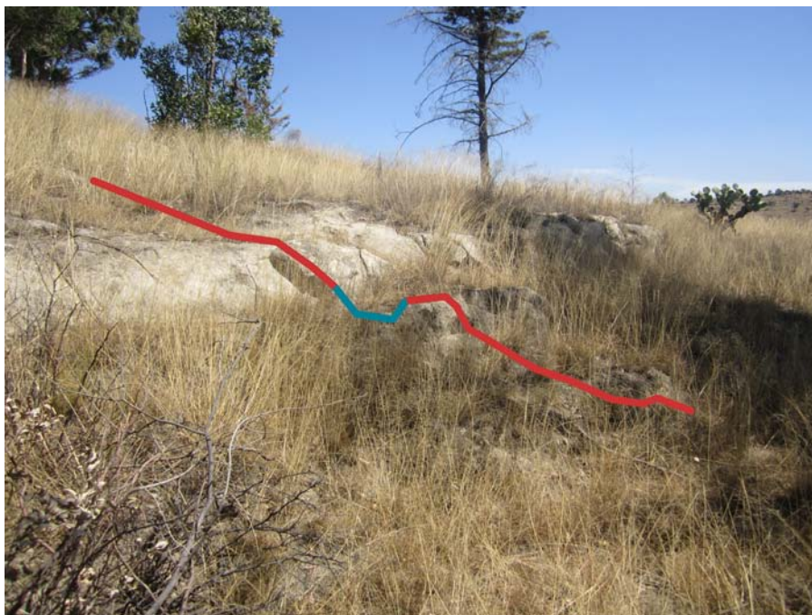
Figura 23. Canal en sustrato litológico mixto recubierto de tezontle en ladera. Fotografía y edición Laura Valera Pérez.
