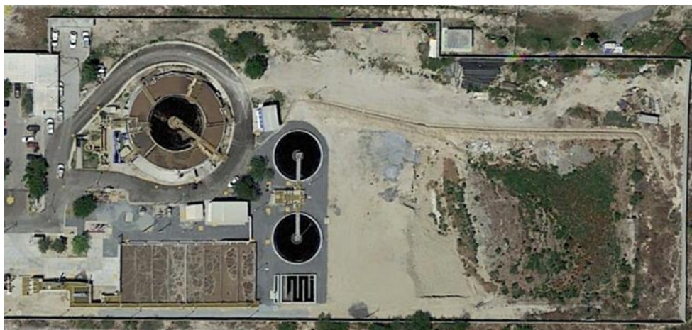
Figura 5.3.10 Imagen de la PTAR García (Google s.f. h)
