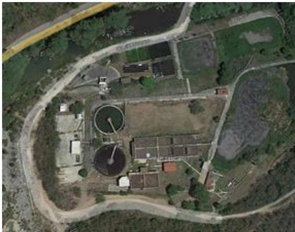
Figura 5.3.22 Imagen de la PTAR Santiago (Google s.f. n).
