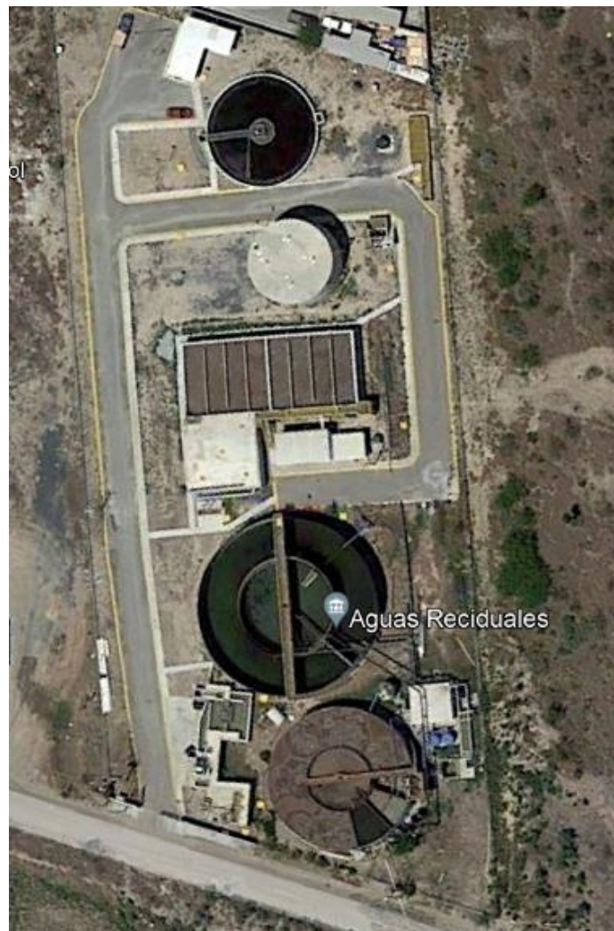
Figura 5.3.20 Imagen de la PTAR San Miguel Interpuerto (Google s.f. m).
