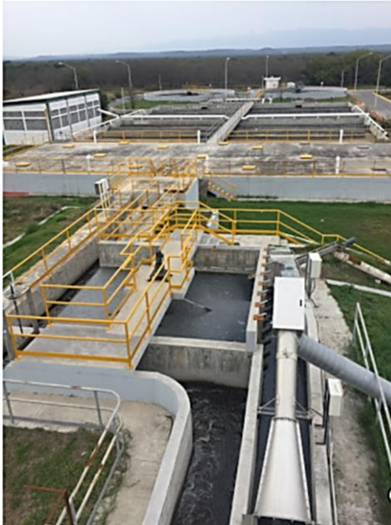
Figura 5.3.16 Imagen de la PTAR Pesquería II (Google s.f. k).
