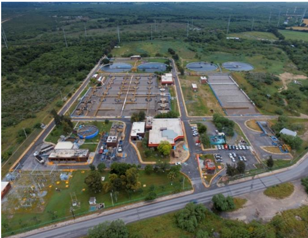
Figura 5.3.2 Imagen de la PTAR Noreste (Google, s.f. d)
