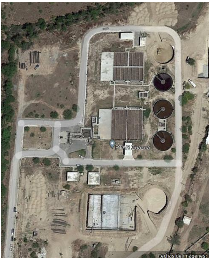
Figura 5.3.14 Imagen de la PTAR General Zuazua (Google s.f. j)
