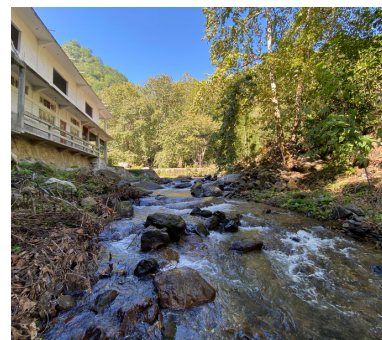
Modificación con algunas estructuras sólidas
